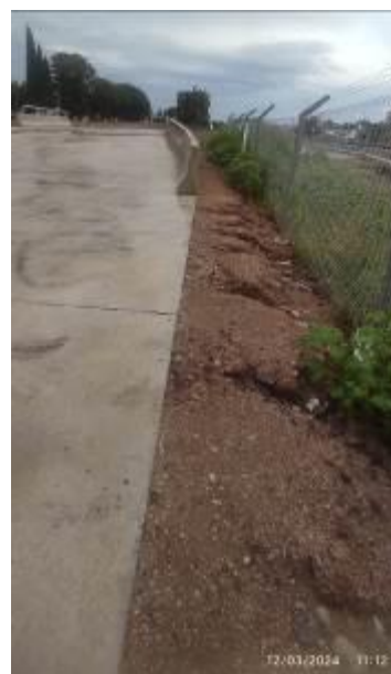
Foto 12.2-1 Erosiones y falta de recuperación ambiental del suelo del entorno
