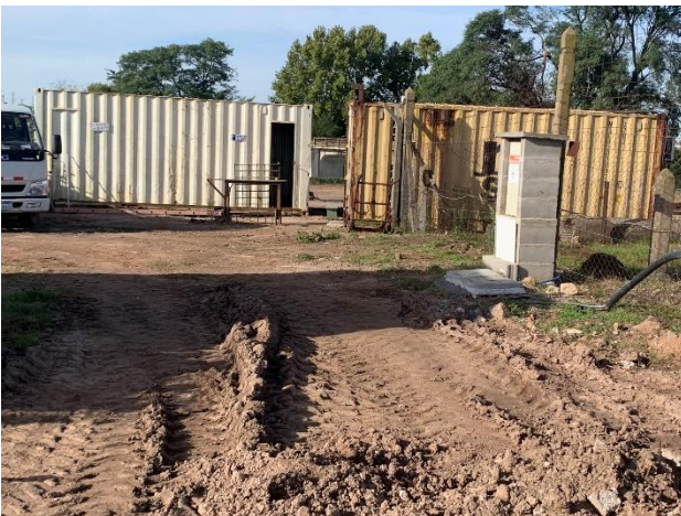
Foto 12.1-3, P03. Contenedores de oficinas permanecen en predio obrador, a ser desmontados en breve.
