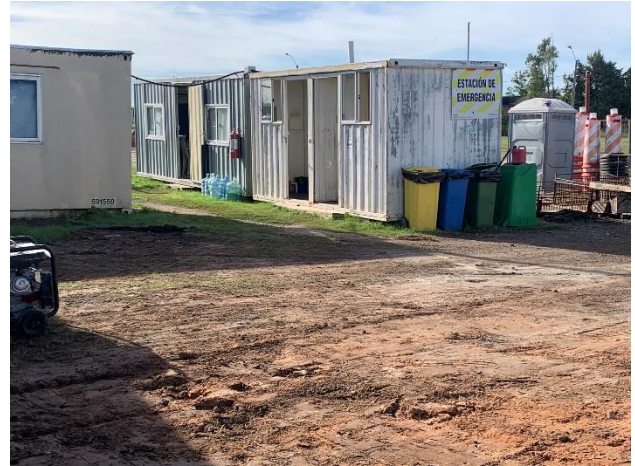
Foto 12.1-2, P03. Infraestructura correcta para gestión segregada de residuos por corriente de generación
