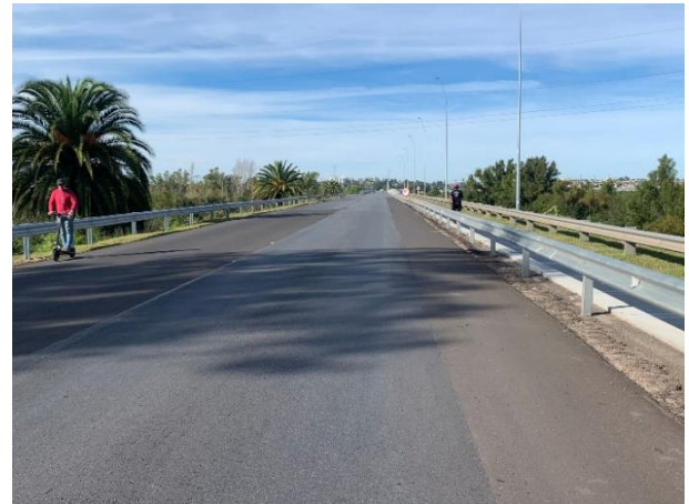
Foto 12.2-2, Tramo terminado. Ensanche de plataforma y carpeta de rodadura en mezcla asfáltica terminadas. Defensas metálicas instaladas.
