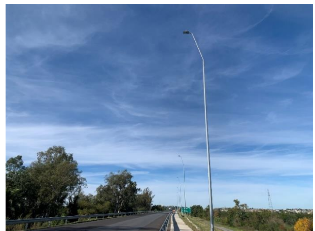
Foto 12.2-4, Tramo terminado. Obras de iluminación terminadas, sucontratista Calex SA.
