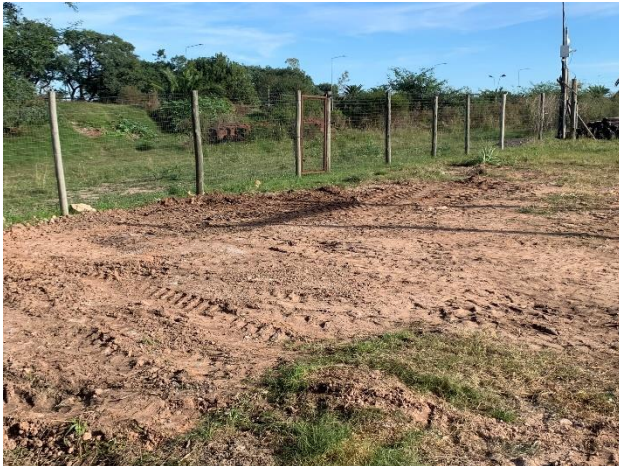
Foto 12.1-5, P03. Pozo impermeable de aguas servidas vaciado, demolido y relleno.
