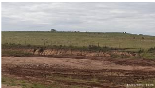
Foto 12.5-1 Erosión en línea de alambrado.
