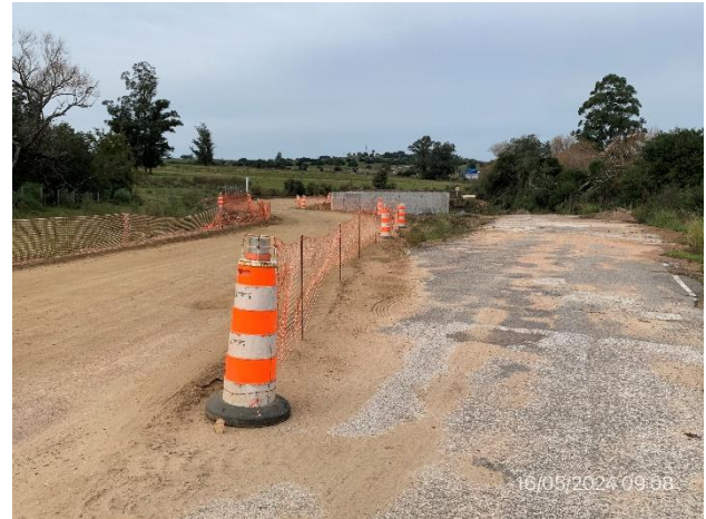
Foto 12.2-2, P01. Inicio de tramo. Alcantarilla tipo H en construcción.
