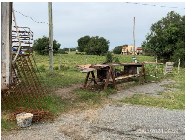
Foto 12.1-9, P03. Obrador, sector de preparación de armaduras, buenas condiciones de orden.
