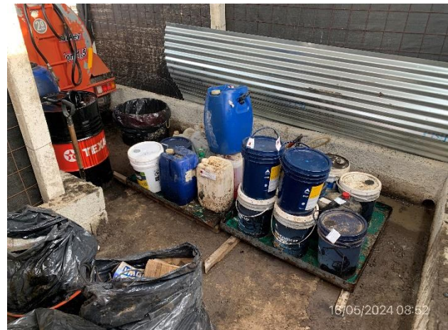
Foto 12.1-4, P03. Obrador, sector techado y con envallado impermeable y bandejas para alojar lubricantes.
