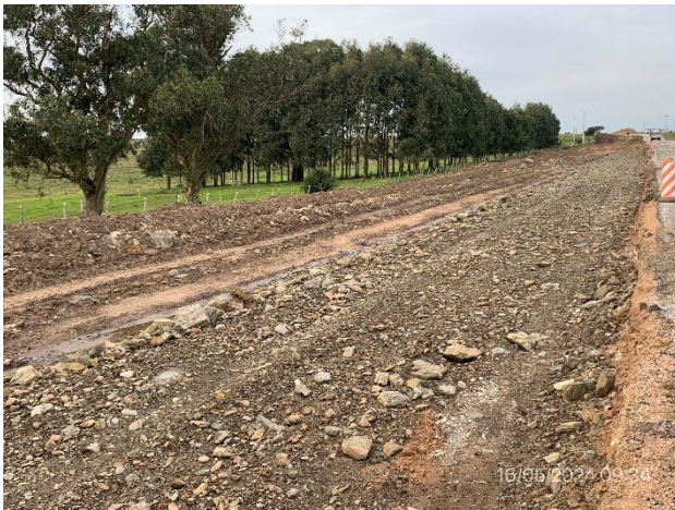
Foto 12.2-5 . Ensayo de sub – base granular en construcción.
