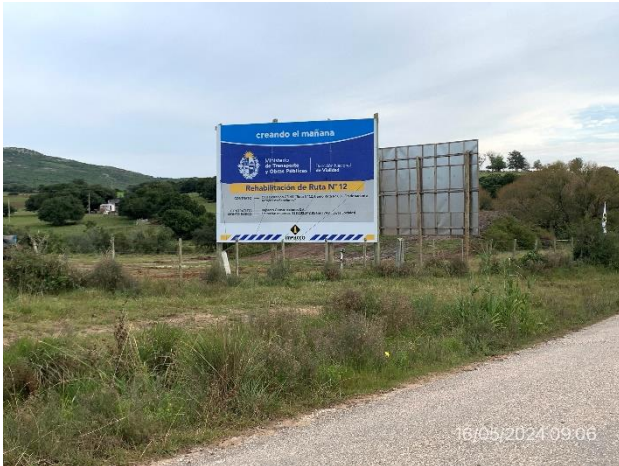
Foto 12.2-1, P01. Inicio de tramo. Variante sobre A° Canelones, Ruta 12 progresiva 374K650.
