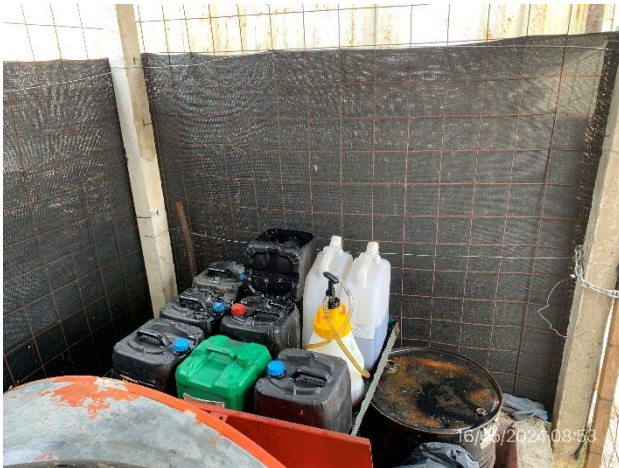
Foto 12.1-5, P03. Obrador, sector techado y con envallado impermeable y bandejas para alojar combustibles.
