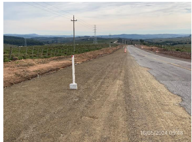
Foto 12.2-4. Ensanche de plataforma granular construido.
