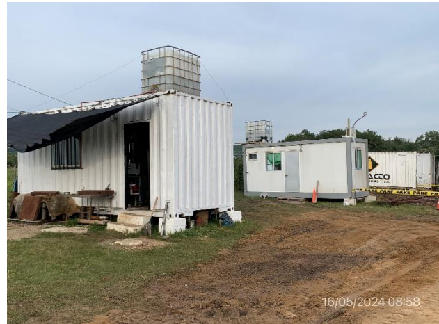
Foto 12.1-2, P03. Obrador, oficinas desmontables con tanque de agua elevado.
