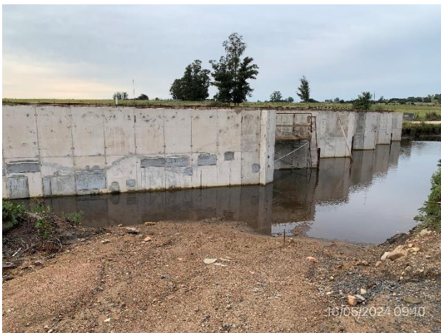
Foto 12.2-3, P01. Alcantarilla H en construcción. Fondo y paredes construidas. Frente de obra inactivo. No se indica la cota de máxima inundación.
