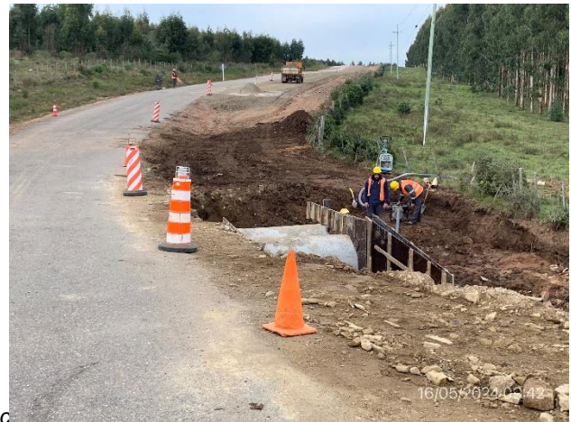
Foto 12.2-6, P04. Frente de obra. Ruta 12 progresiva 360K800. Alcantarilla tipo Z en construcción. No se indica la cota de máxima inundación.
