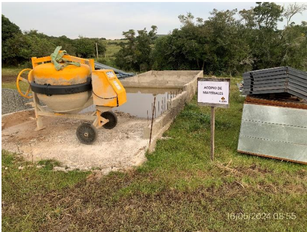
Foto 12.1-7, P03. Obrador, sector de acopio de productos químicos en construcción.
