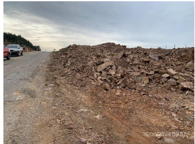
Foto 12.2-10, P05. Frente de obra. Ruta 12 progresiva 355K500. Desmante a terraplén en ejecución.
