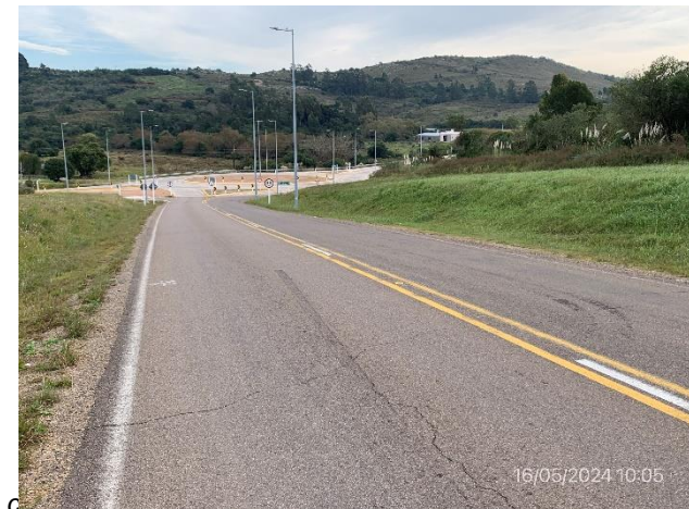
Foto 12.2-12, P02. Fin de tramo. Ruta 12 progresiva 351K910, empalme con Ruta 60.
