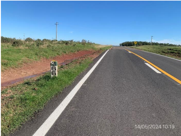
Foto 12.2-1, P01. Inicio de tramo, Ruta 27 progresiva 66K000.
