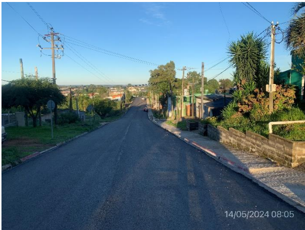
Foto 12.2-7, Vichadero. Desvío de tránsito pesado terminado.
