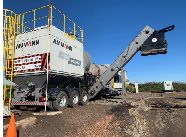
Foto 12.1-2, P05. Planta asfáltica sin actividad
