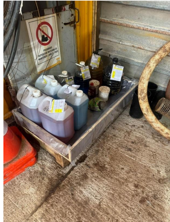
Foto 12.3-2, P02. Pañol, se dispusieron bidones de hidrocarburos en nueva bandeja impermeable.
