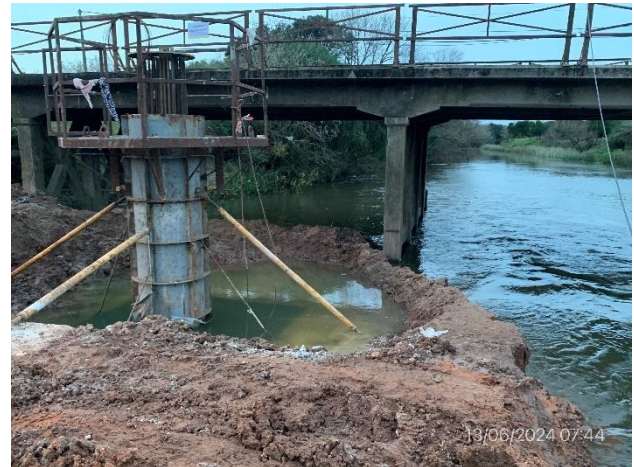
Foto 12.2-4, P01. Trabajos en ejecución de encofrado de pilares.
