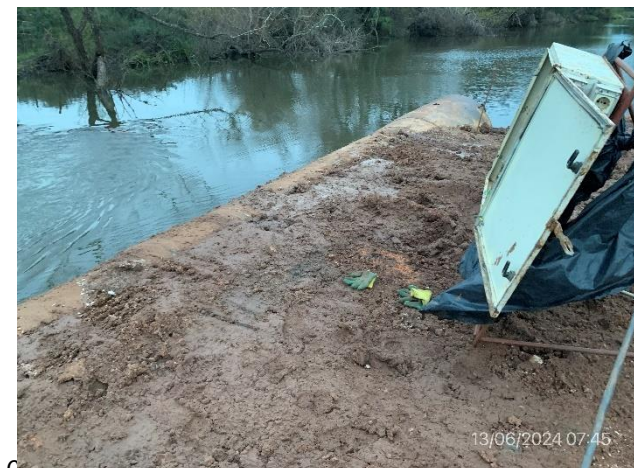
Foto 12.2-6, P01. Residuos plásticos dispersos por ausencia de infraestructura para gestión de residuos a pie de obra.
