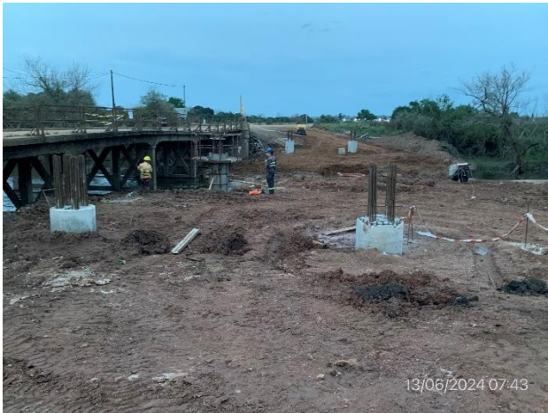
Foto 12.2-3, P01. Ataguía construida, pilotaje ejecutado
