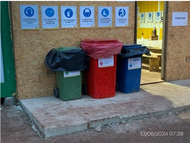
Foto 12.1-3, P02. Estación para acopio temporal de residuos segregados por corriente de generación.
