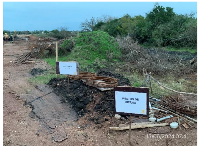
Foto 12.1-10, P02. Acopio de materiales en zona inundable.
