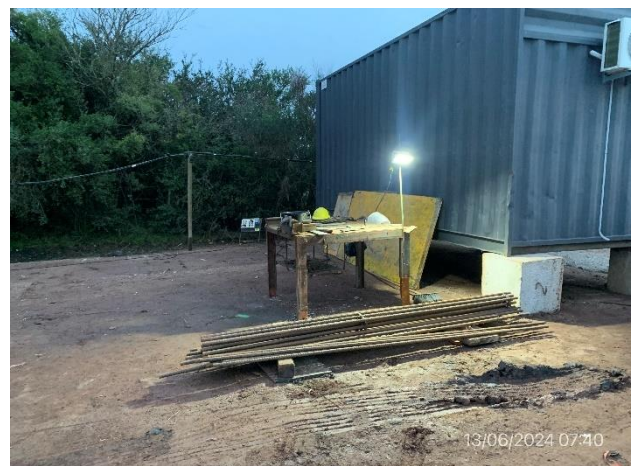
Foto 12.1-6, P02. Estación de fabricación de armaduras instalada en zona inundable.
