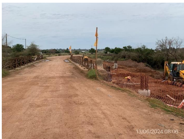
Foto 12.2-1, P01. Nuevo Puente en obra. Ruta 81 sobre A° Solís Grande, Paso Real.
