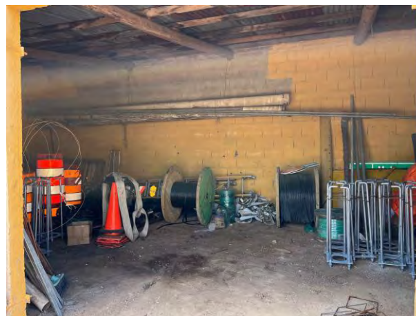
Materiales de obra
