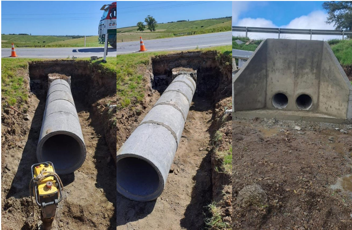
Imagen N°4 y 5: Colocación de caños de alargue de alcantarillas en ensanche 7. Imagen N°6: Hormigonado de cabezal de alcantarilla en ensanche 6.
