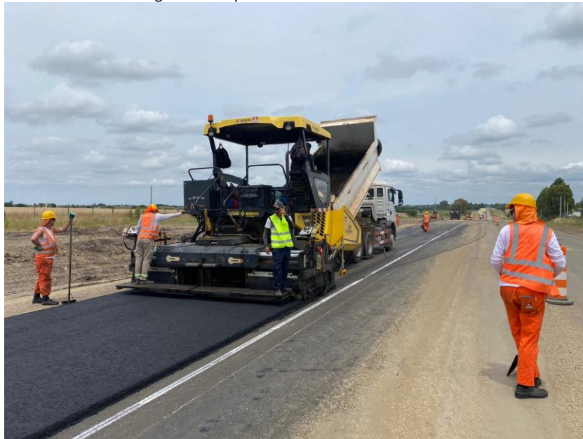
Imagen N°10: Capa de rodamiento en ensanche 3.
