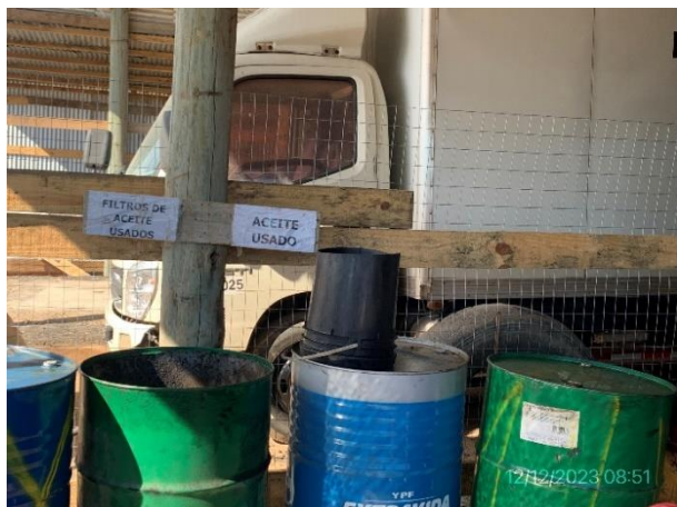
Foto 12.1-7, P03. Obrador, sector envallado para acopio de aceites usados y residuos contaminados con hidrocarburos.
