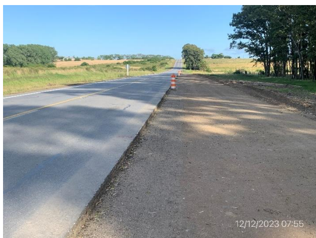
Foto 12.2-5. Ruta 23, ensanche de plataforma. Base granular compactada ejecutada.
