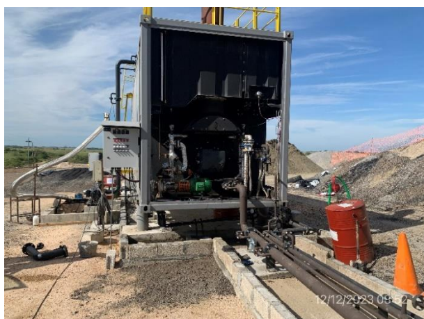
Foto 12.1-9, P03. Planta asfáltica, envallados adecuados para prevención de derrames.
