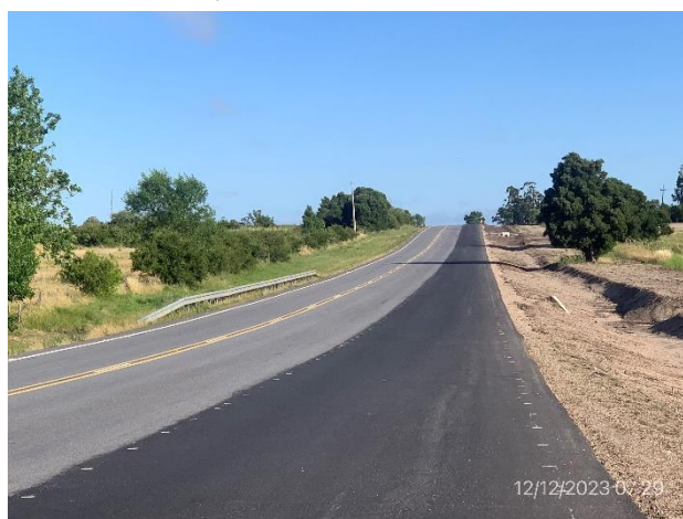
Foto 12.2-6. Ruta 23, terceras vías con carpeta asfáltica ejecutada.
