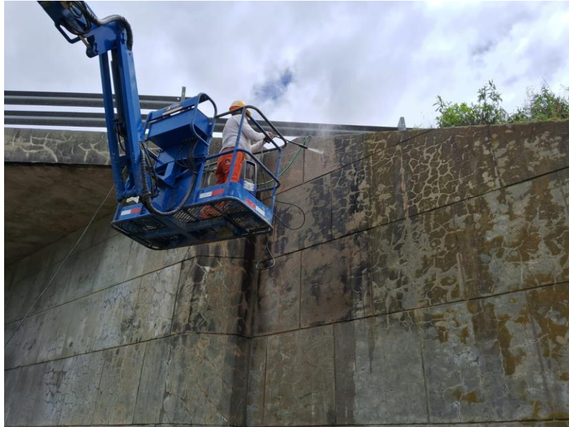
Imagen N°17 y 18: Limpieza y reparación puente FFCC ruta 12.
