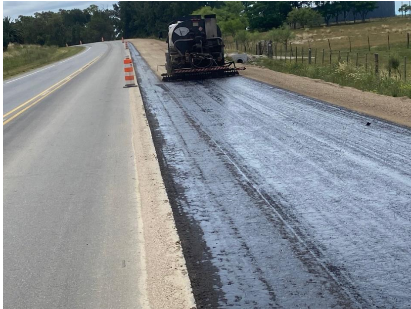
Imagen N°14: Imprimación asfáltica ensanche 3.
