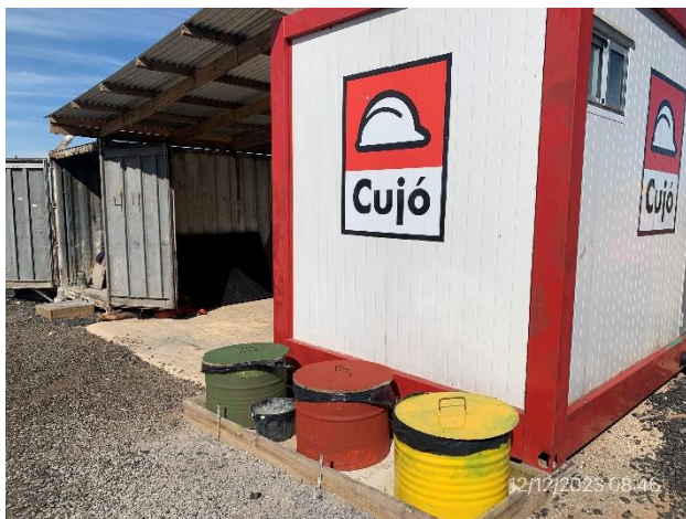
Foto 12.1-3, P03. Obrador, estación de acopio transitorio de residuos segregados por corriente de generación.
