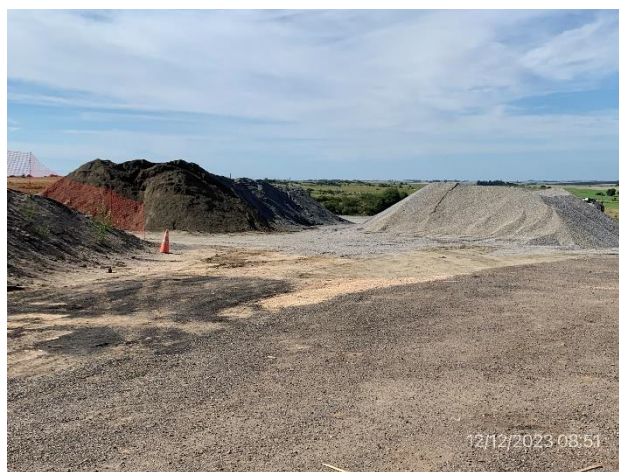
Foto 12.1-2, P03. Obrador, zona de acopio de áridos y explanada de maniobras.
