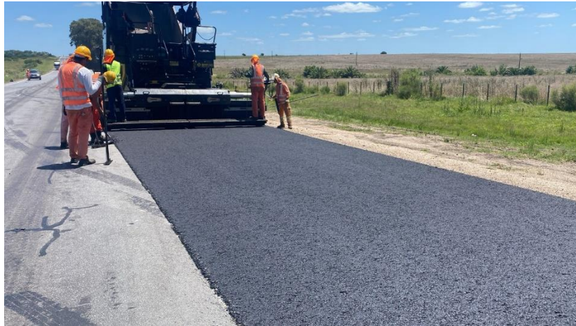
Imagen N°9: Capa de rodamiento en ensanche 3.
