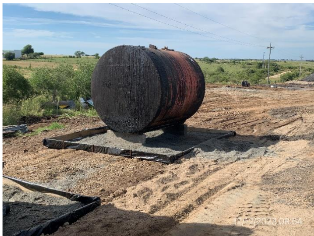
Foto 12.1-11, P03. Planta asfáltica, depósito de emulsión asfáltica en sector envallado, no alcanza a contener el 110% del volumen del tanque.
