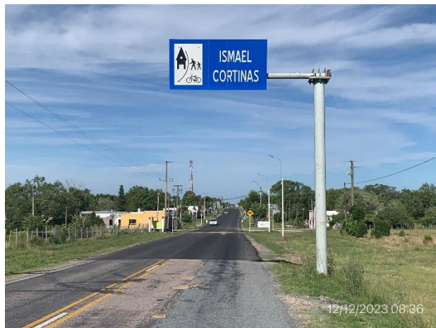
Foto 12.2-4, P02. Fin de obras en Ruta 23, progresiva 152K200, acceso Este a Ismael Cortinas.
