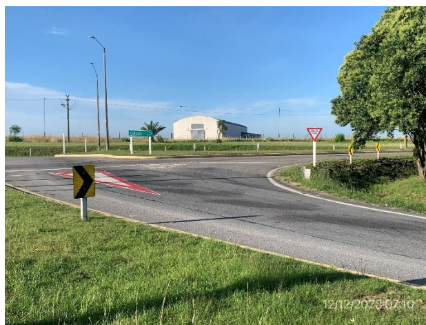
Foto 12.2-2, P01. Inicio de obra, Ruta 23, progresiva 100K000, empalme con Ruta 11.
