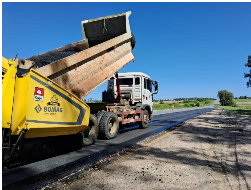
Imagen N°15: Capa de rodamiento en Camino San Alberto.
