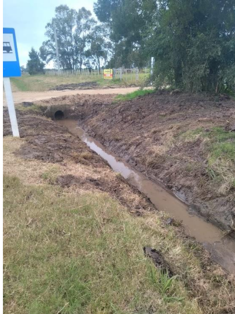
Imagen N°7: Mantenimiento de alcantarillas obstruidas.
