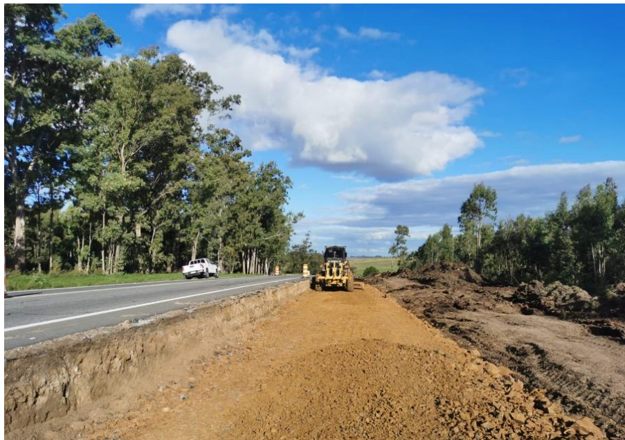
Imagen N°6: Excavación de cajón ensanche 7.
