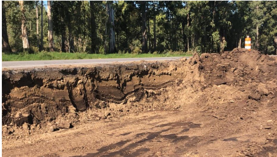
Imagen N°5: Excavación del diente en ensanche de carril número 7.
