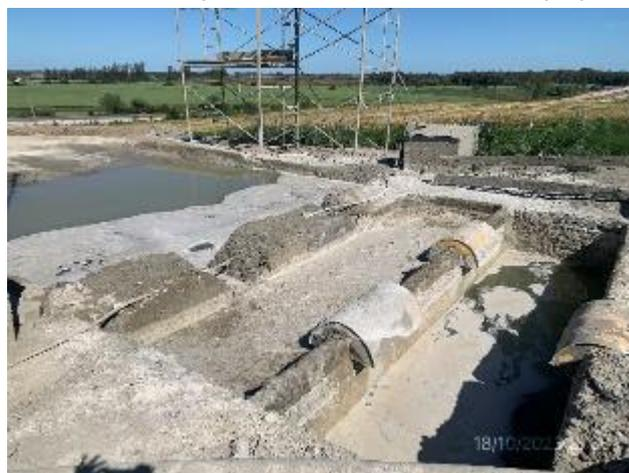
Foto 12.2-10, P03. Planta de hormigón, piletas de decantación
