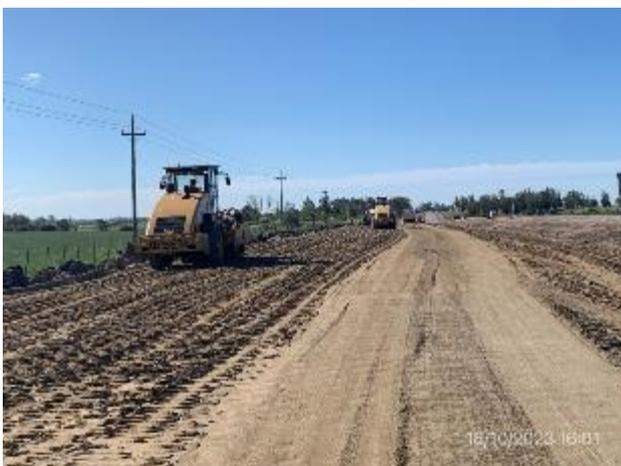
Foto 12.1-15. Tramo de obra. Construcción de base granular
