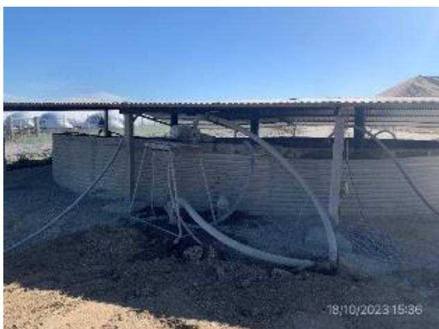
Foto 12.2-11, P03. Planta de hormigón. Tanque australiano con sistema de recuperación
