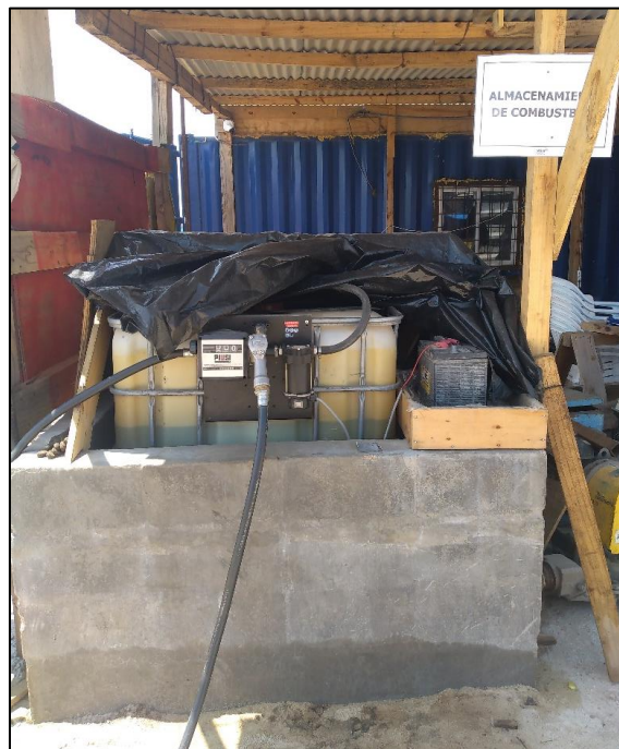
Figura 3-3 Recinto de combustible en Obrador.
