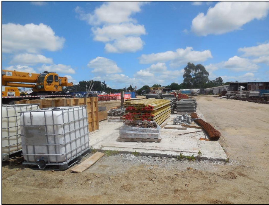
Figura 3-5 Platea para piezas prefabricadas de hormigón armado
