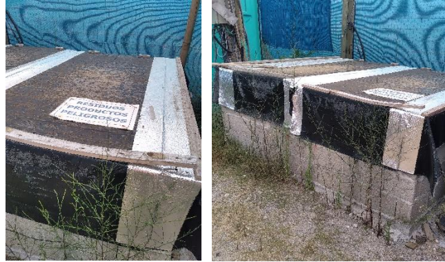
Figura 3-9 Recinto para Residuos Peligrosos
