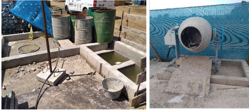
Figura 3-10 Sistemas de lavado y contención de efluente de hormigón en obra.
