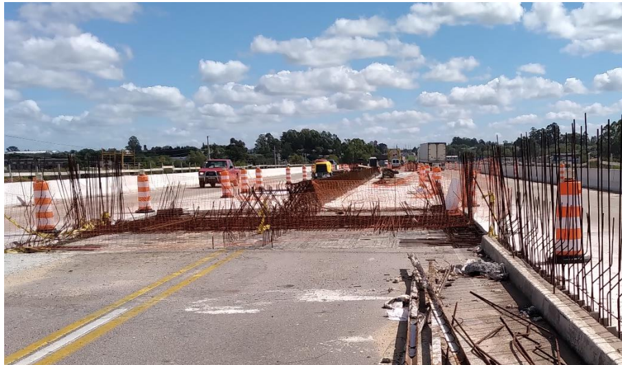
Figura 3-5 Armado de hierros para losa de puente vehicular
