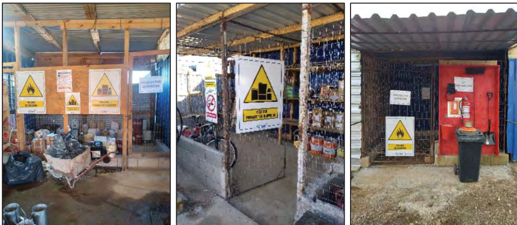
Figura 3-4 Recintos para sustancias peligrosas
