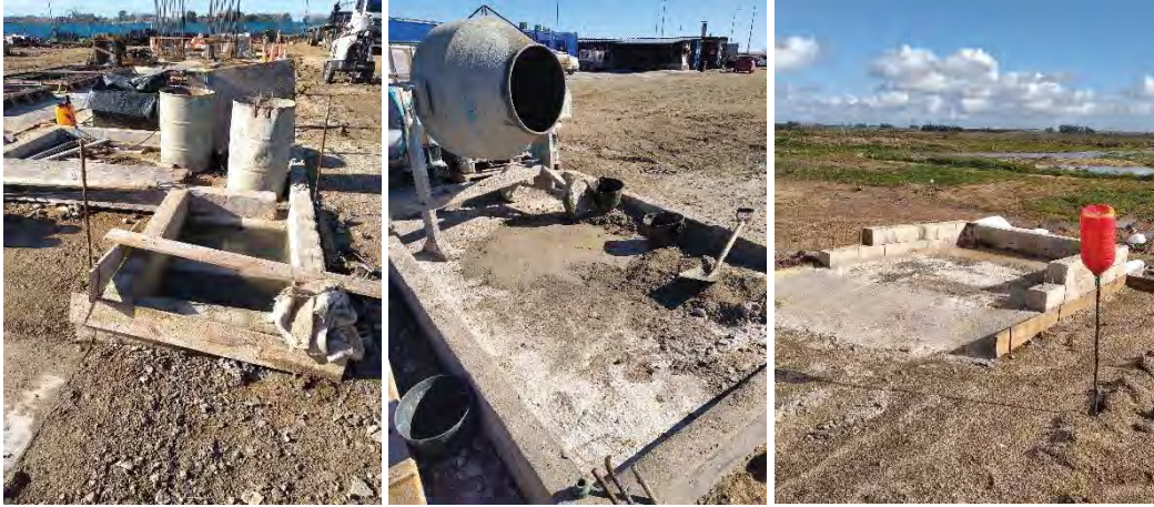
Figura 3-11 Sistemas de lavado y contención de efluente de hormigón en obra.
