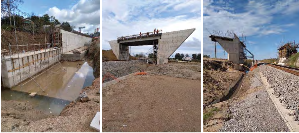
Figura 3-6 Estructuras de hormigón armado construidas en el trimestre
