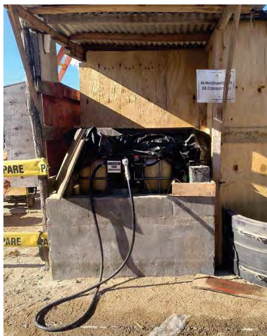
Figura 3-3 Recinto de combustible en obrador secundario.
