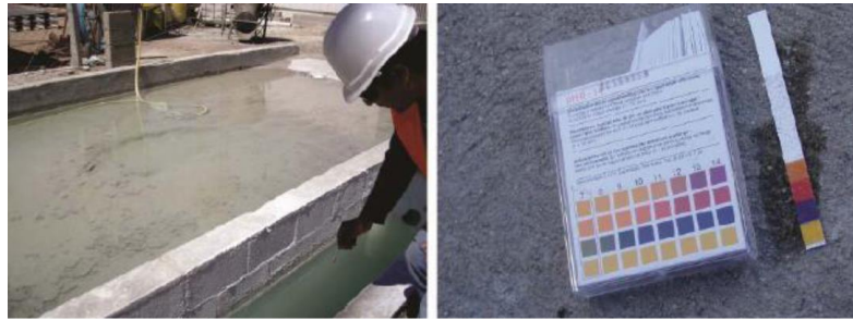
Figura 7-3: Ejemplo de medición de pH en efluentes de hormigón, utilizando cintas de pH.
