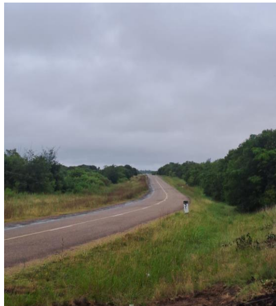
Tramo 14km500 al 33km000
