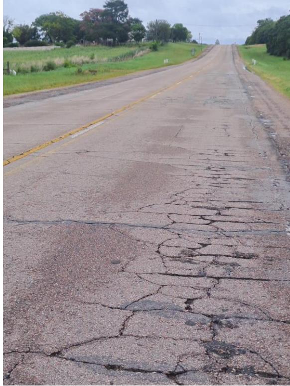
Tramo 5km100 al 14km500
