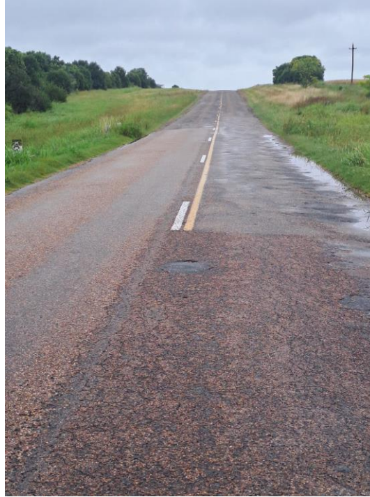
Tramo 14km500 al 33km000
