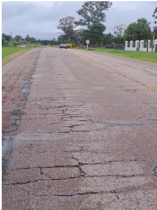
Tramo 5km100 al 14km500
