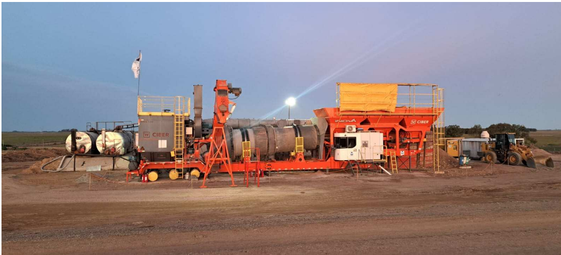
Imágenes de la implantación de la planta asfáltica
