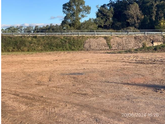
Foto 12.2-1, P04. Obrador desmontado de Molinsur SA. Padrón Urbano n° 317, Enrique Martínez. Predio limpio, sin ROCs u otros residuos.
