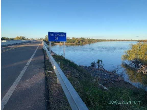
Foto 12.1-1, P01. Nuevo puente en La Charqueada terminado y abierto al tránsito
