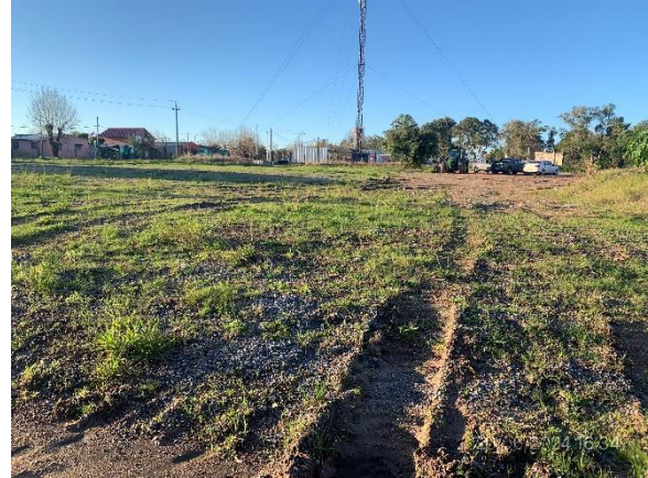
Foto 12.2-2. P04. Empastado vegetal ejecutado en zona de obrador. La cámara sin tapa fue demolida y rellenada.
