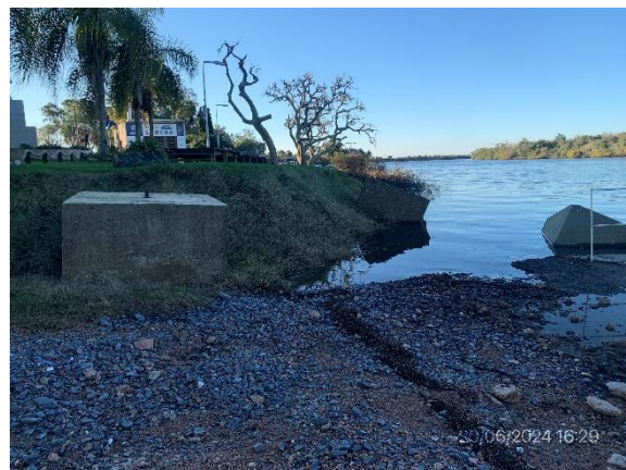
Foto 12.1-5. P01 Estructuras permanentes quedan en el lecho del Río Cebollatí con autorización Alcaldía.
