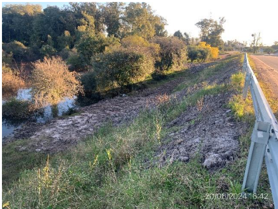
Foto 12.1-9. P01 Talud de terraplen de acceso Este de Ruta 91 a (+) con señales de erosión.
