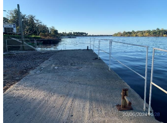
Foto 12.1-2. P01. Muelle de obra reacondicionado como muelle peatonal abierto al público.
