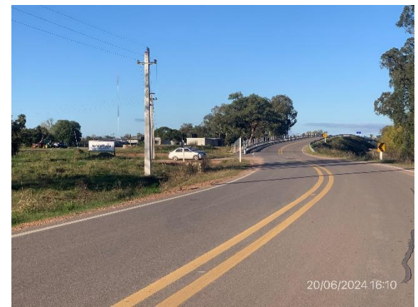
Foto 12.1-6. P01 Acceso Oeste terminados, abierto al tránsito y con señalización definitiva .
