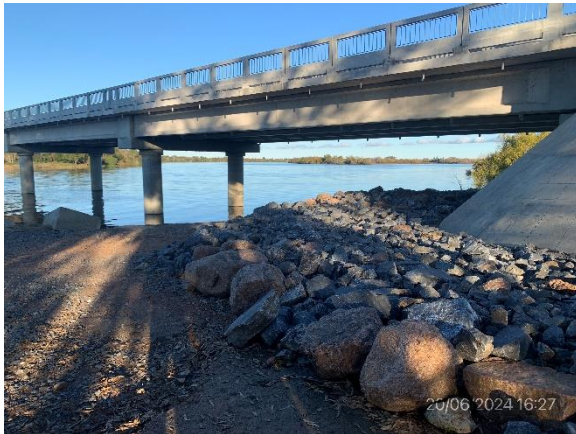
Foto 12.1-3. P01. Nuevo puente en La Charqueada, enrocado culminado en cabecera Oeste
