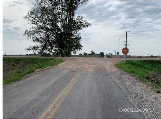
Foto 12.1-8, P02. Fin de tramo. Ruta 63 progresiva 15K900, empalme con Ruta 5.
