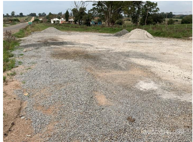
Foto 12.1-4. P04. Acopio transitorio de materiales en Ruta 63 progresiva 12K500 a (+).
