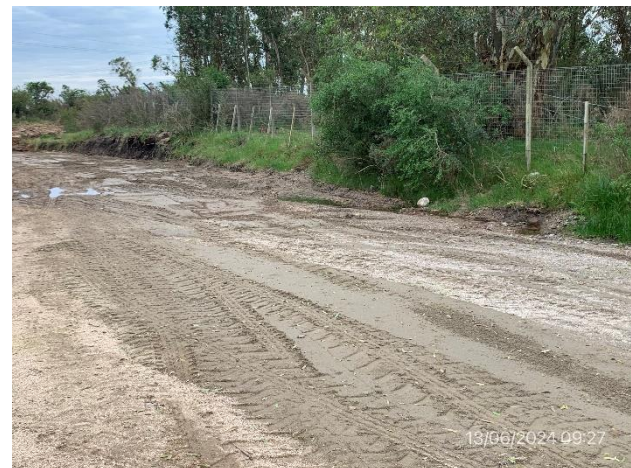
Foto 12.2-2, P03. Explanada granular compactada queda a beneficio de Intendencia de Canelones para futura calle.
