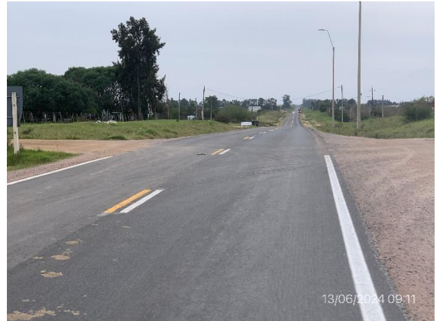
Foto 12.1-2, P01. Inicio de tramo, Ruta 63 progresiva 0K800. Empalme con Ruta 11.
