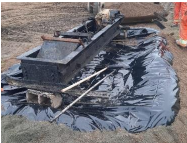
Foto 12.3-1, Tanque con hidrocarburos, se construyó bandeja de contención impermeable.
