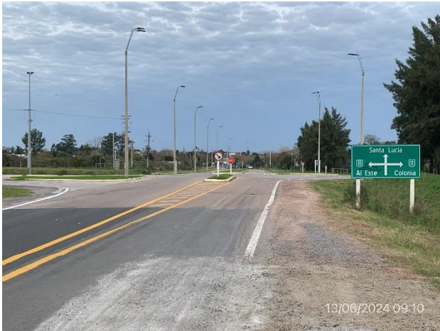
Foto 12.1-1, P01. Inicio de tramo, Ruta 63 progresiva 0K800. Empalme con Ruta 11.
