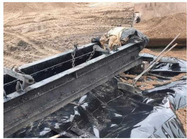
Foto 12.3-2 Tanque con hidrocarburos, se construyó bandeja de contención impermeable
