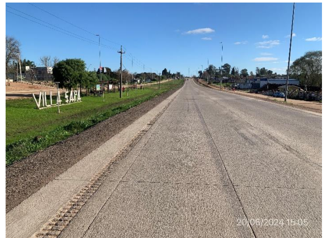
Foto 12.2-4. Sector de travesía urbana por Villa Sara construida y abierta al tránsito.
