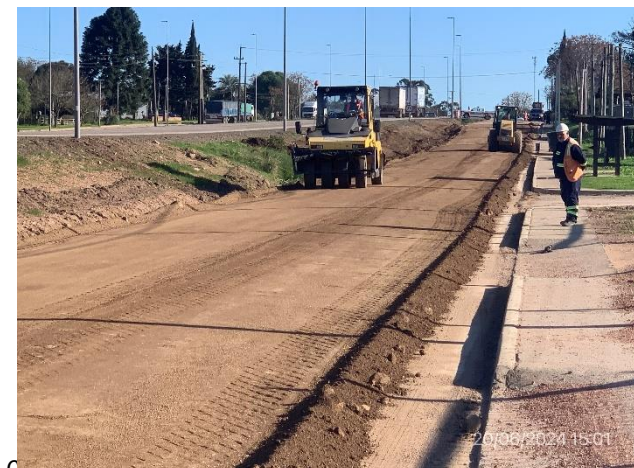
Foto 12.2-6, P04. Tendido y compactación de base granular en ejecución.
