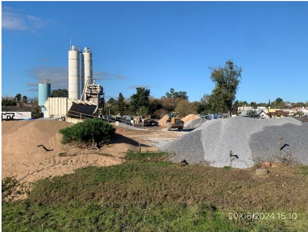
Foto 12.1-1, P03. Destacamento MTOP, obrador y planta de hormigón. Padrón urbano N° 6315, Treinta y Tres.
