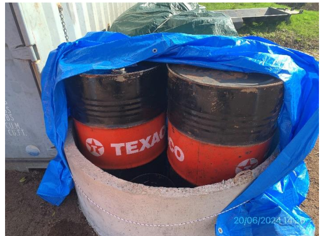
Foto 12.1-10, P03. Tarrinas de lubricantes alojadas en recinto envallado y con pavimento impermeable.
