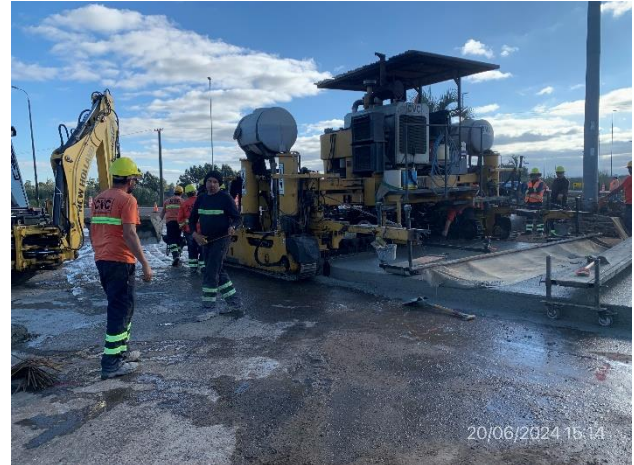
Foto 12.2-8, P02. Ejecución de tendido de carpeta de hormigón con terminadora.
