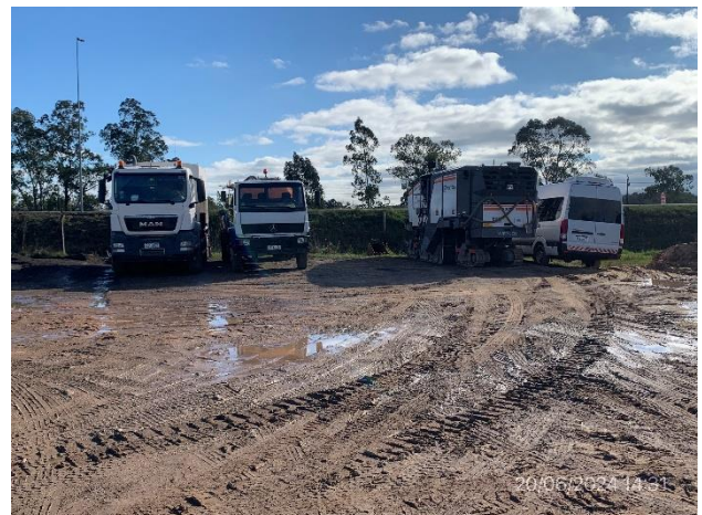
Foto 12.1-6, P03. Explanada granular para estacionamiento y maniobras de maquinaria.
