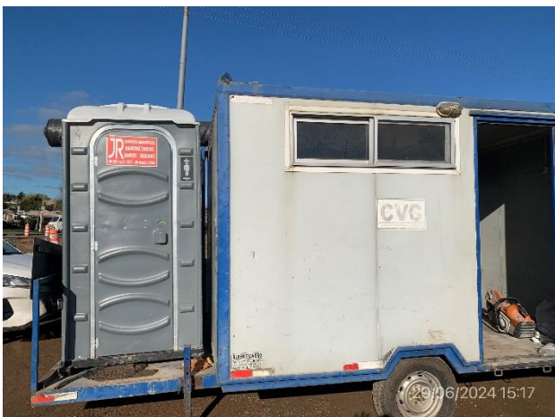
Foto 12.2-11, P02. Campamento provisorio, no está dotado de infraestructura adecuada para acopio temporal de residuos de forma segregada por origen.
