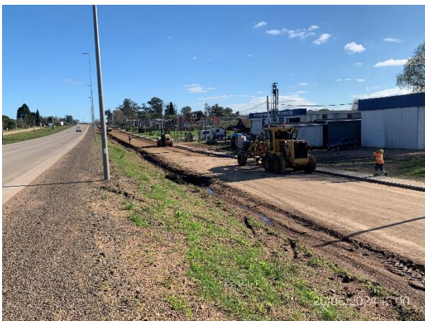
Foto 12.2-5, P04. Frente de obra, Ruta 8 progresiva 282K300 a (-).
