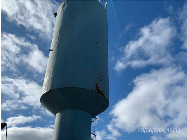
Foto 12.1-7, P03. Tanque de agua no potable, cargado a partir de tomas de agua autorizadas.
