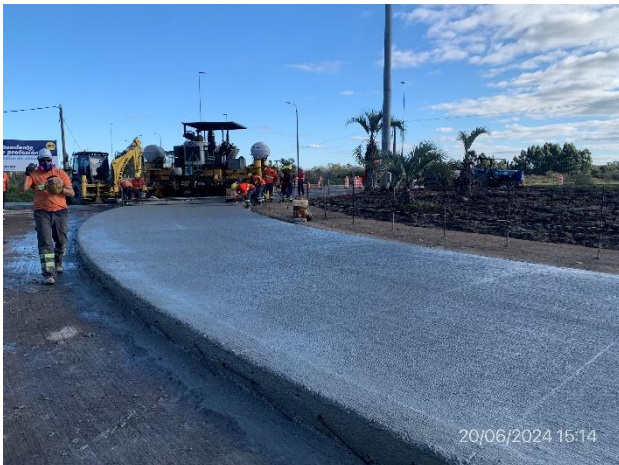
Foto 12.2-9, P02. Rotonda en construcción en tramos por media calzada.
