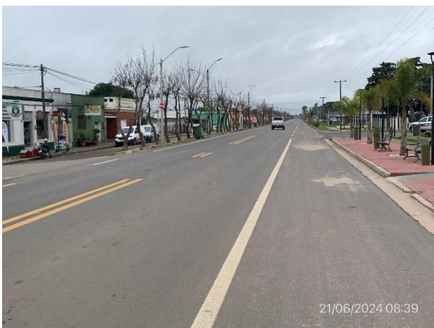
Foto 12.2-11. Obras obligatorias terminadas de Ruta 23 en planta urbana de Ismael Cortinas, obras de señalización culminadas.
