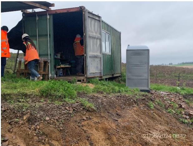
Foto 12.1-11, P04. Pañol y campamento provisorio con servicios de bienestar adecuados.
