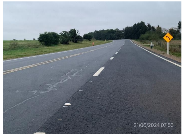
Foto 12.2-6. Sector de Ruta 23, con terceras vías abiertas al tránsito con carpeta asfáltica terminada, senda a (+).
