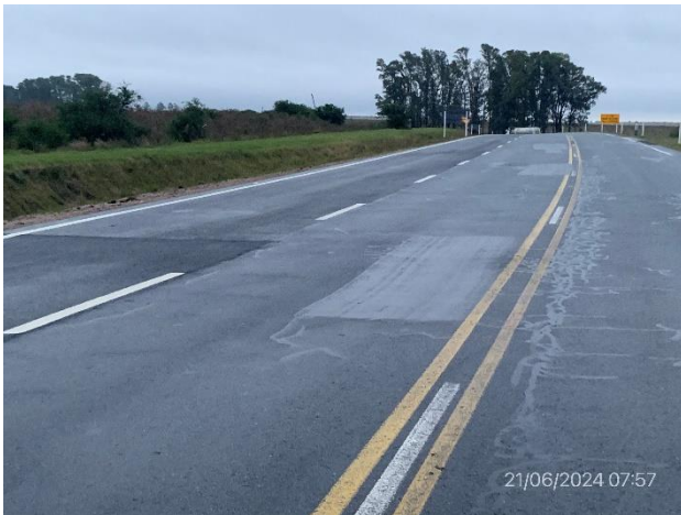
Foto 12.2-7. Sector de Ruta 23, con terceras vías abiertas al tránsito con carpeta asfáltica terminada, senda a (-).
