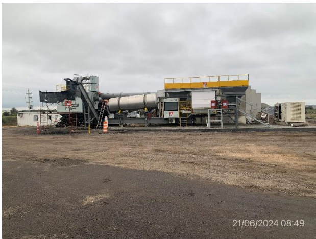
Foto 12.1-1, P03. Obrador y planta asfáltica de José Cujó S.A. Padrón 24448 de la 5ª SC de Colonia. Vista general.
