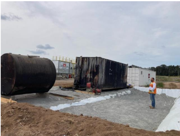
Foto 12.3-3, P03. La empresa ejecutó una nueva explanada envallada impermeable para el depósito de emulsiones asfálticas.
