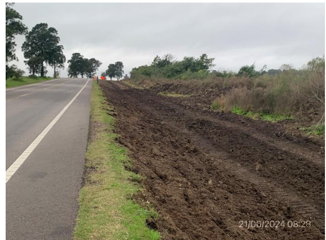
Foto 12.2-10, P06. Movimiento de suelos y apertura de caja en subrasante para ensanche de terceros carriles en ejecución.
