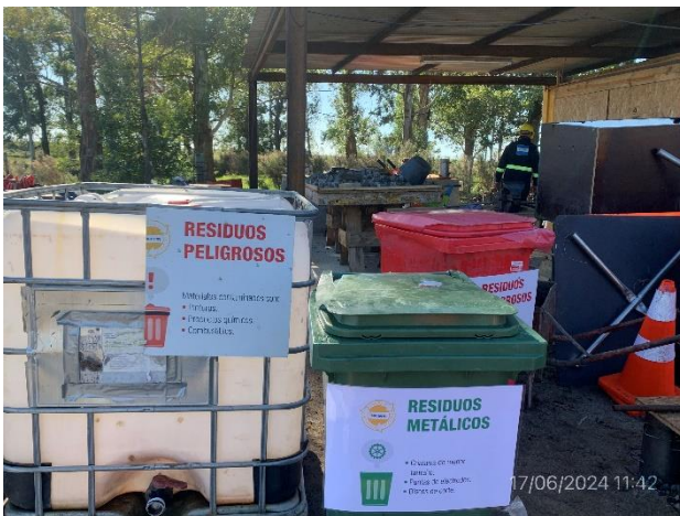
Foto 12.1-11, P02. Obrador, laboratorio de hormigón dotado de infraestructura para acopio temporal de residuos segregados por corriente de generación.
