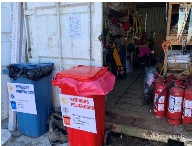
Foto 12.1-9, P02. Obrador, estación para acopio temporal de residuos segregados por corriente de generación.
