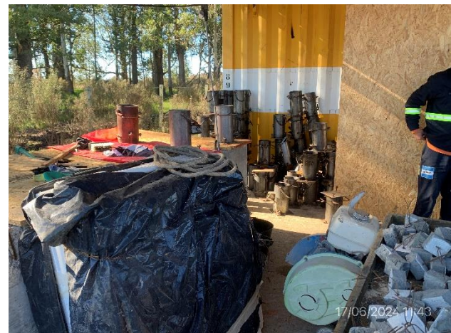
Foto 12.1-12, P02. Obrador, laboratorio de hormigón. Acopio de probetas a ensayar.
