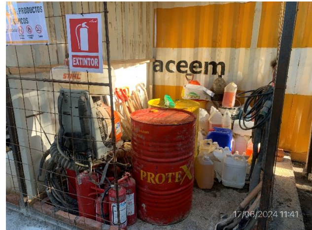
Foto 12.1-8, P02. Obrador, tarrinas y bidones de lubricantes y productos químicos en recinto envallado, techado y con pavimento impermeable.
