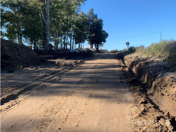
Foto 12.1-1, P02. Obrador, cabecera Sur del puente sobre A° Juncal. Ruta 3 progresiva 197K400 a (+).
