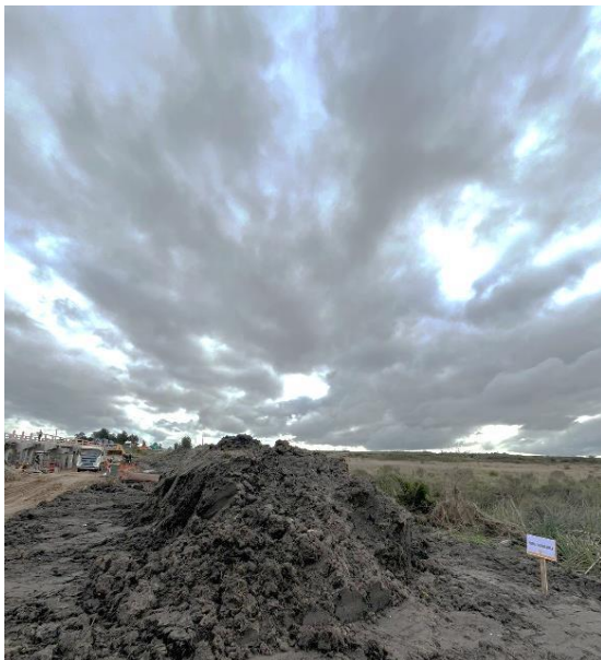
Foto 12.3-3, P01. Cabecera Sur del puente, se demarcó zona de máxima inundación. No hay acopios temporales.
