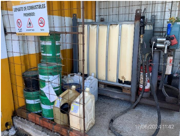
Foto 12.1-7, P02. Obrador, tanque y surtidor de combustible en recinto envallado, techado y con pavimento impermeable.
