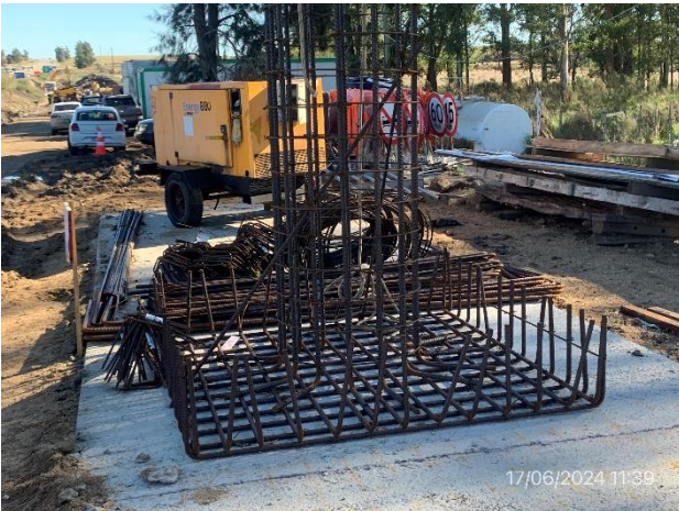
Foto 12.1-3, P02. Obrador, sector de acopio de armaduras terminadas.
