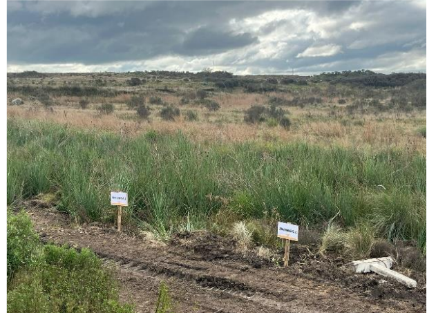
Foto 12.3-2, P01. Cabecera Norte del puente, se demarcó zona de máxima inundación. No hay acopios temporales.
