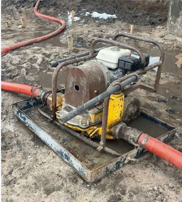
Foto 12.3-1, P01. Frente de obra, se complementó la motobomba con una bandeja para contención de eventuales derrames.
