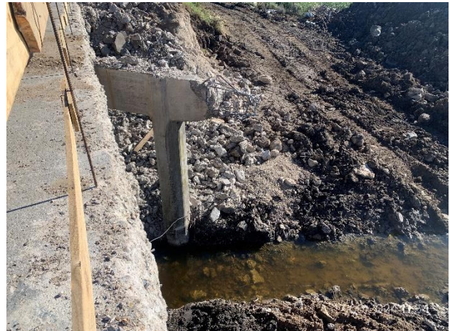
Foto 12.2-4, P01. Curso desviado aguas abajo del A° Juncal en buenas condiciones de limpieza y escurrimiento.
