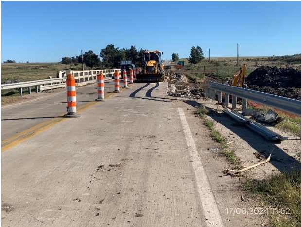
Foto 12.2-1, P01. Puente sobre A° juncal en obra. Ruta 3 progresiva 197K620.
