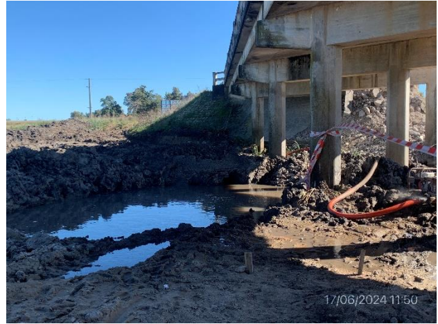
Foto 12.2-8, P01. Curso aguas abajo del A° Juncal, buenas condiciones de limpieza y escurrimiento.
