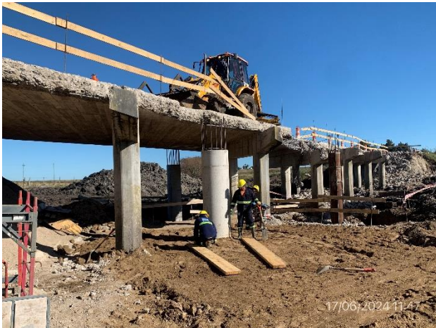
Foto 12.2-3, P01. Atagüía granular construida
