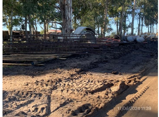
Foto 12.1-2, P02. Obrador, sector de acopio de armaduras en proceso.
