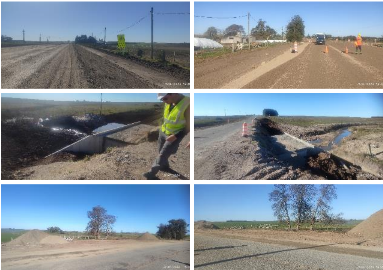
Foto 12.5-1 Vistas del tramo en obra.
