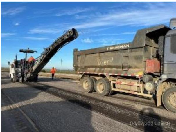
Foto 12.1-15. P08, Frente de obra. Tendido de pavimento con terminadora de hormigón. Ruta 5 progresiva 108K400 a (+). Escarificado en ejecución.
