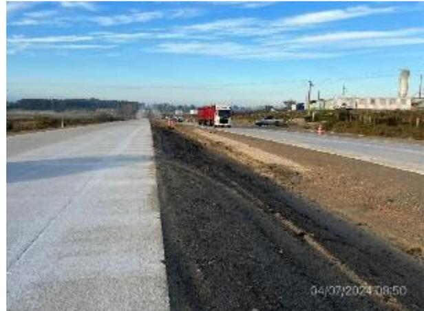
Foto 12.1-2. Tramo de Ruta 5 con cunetas perfiladas y cubiertas con suelo vegetal.
