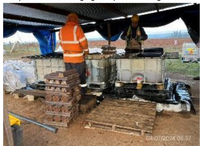
Foto 12.2-12, P03. Obrador, estación de engrasado de pasadores montada sobre envallado impermeable.
