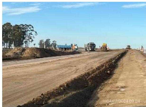
Foto 12.1-12, P07. Frente de obra, movimiento de suelos y ejecución de terraplenes. Ruta 5 progresiva 112K400 a (+).
