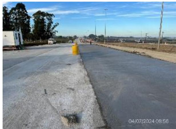
Foto 12.1-10, P06. Sector de pavimento de hormigón manual ejecutado.
