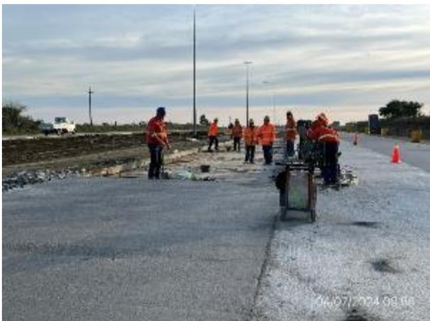
Foto 12.1-9, P06. Frente de obra, tendido manual de pavimento de hormigón. Ruta 5 progresiva 108K400 a (+).
