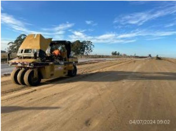
Foto 12.1-13. P07, ejecución de recargo de base granular compactada.
