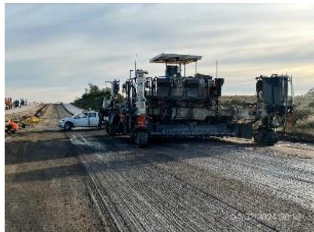
Foto 12.1-16. P08, tendido de pavimento con terminadora de hormigón.
