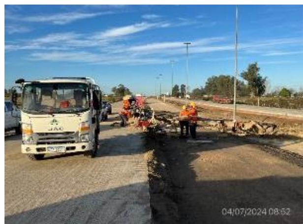
Foto 12.1-6, P05. Frente de obra. Alcantarilla en construcción. Ruta 5 progresiva 107K700.
