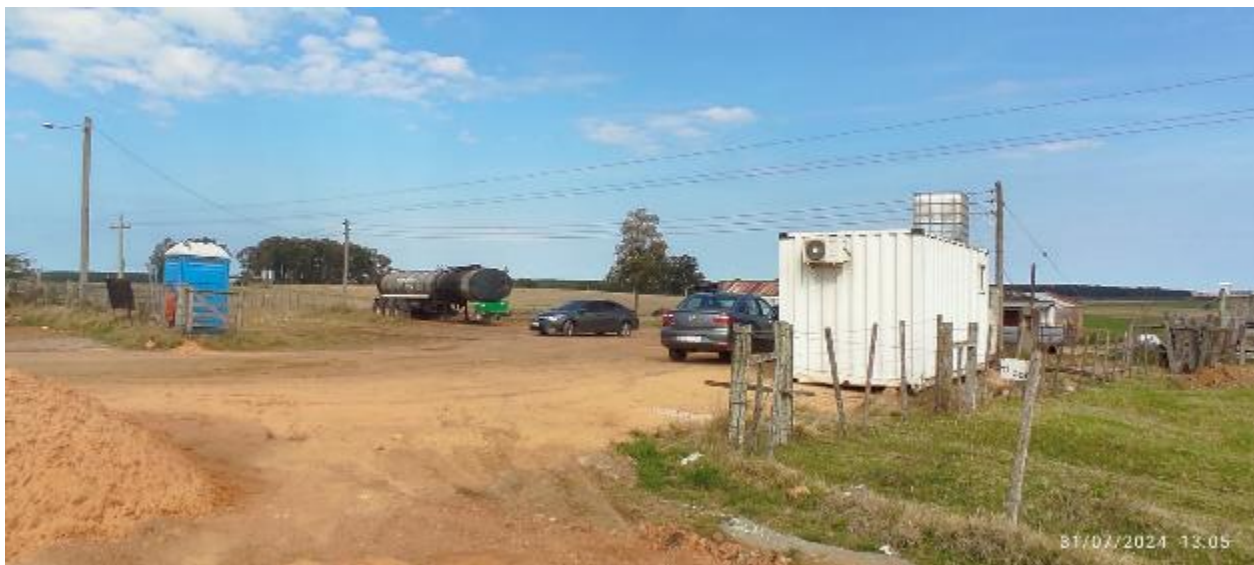
Foto 12.11-1 Obrador Auxiliar en Ruta 27.
