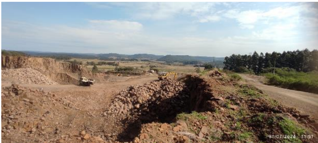
Foto 12.5-1 Barranco en cantera próximo a camino, sin señalizar.
