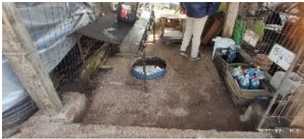
Foto 12.4-1 Estructura inadecuada de dique para hidrocarburos y residuos especiales.
