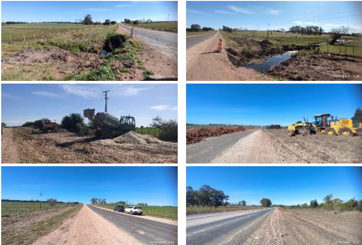
Foto 12.3-1 Vistas del tramo en obra.
