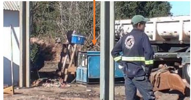
Foto 12.1-1 Generador sin dique de contención.
