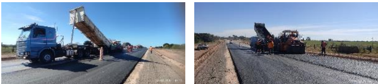
Foto 12.3-2 Tendido de asfalto.
