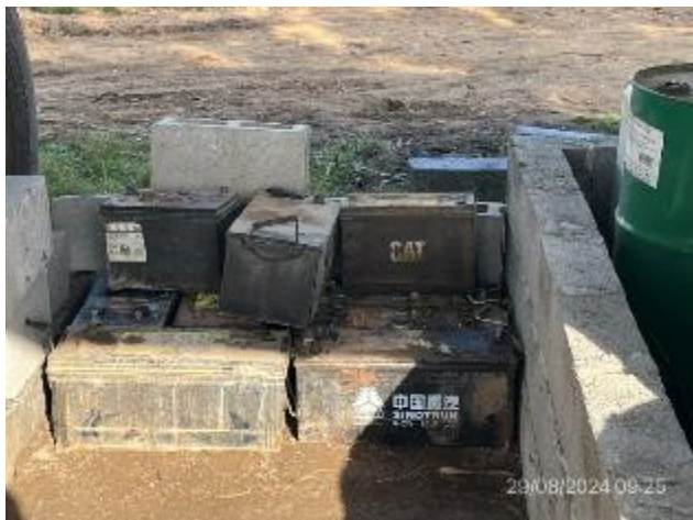
Foto 12.2-7, P03. Baterías alojadas en sector correctamente envallado.
