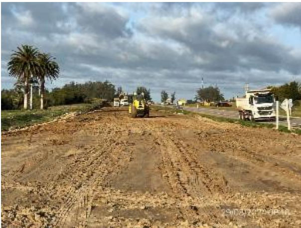
Foto 12.1-3, P07. Frente de obra, tendido y compactación de base granular.
