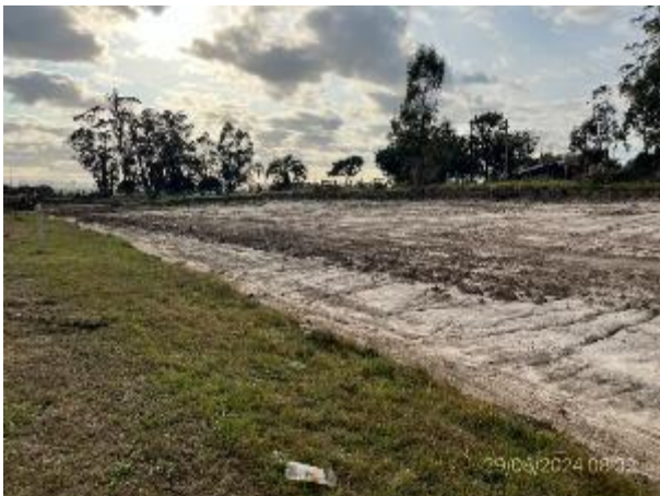
Foto 12.1-5. Ruta 9, tramo con subrasante conformada, a la espera de recargo granular.
