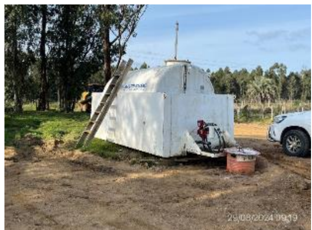
Foto 12.2-6, P03. Tanque surtidor de combustible, envallado correcto y tarrina de acopio de residuos contaminados.
