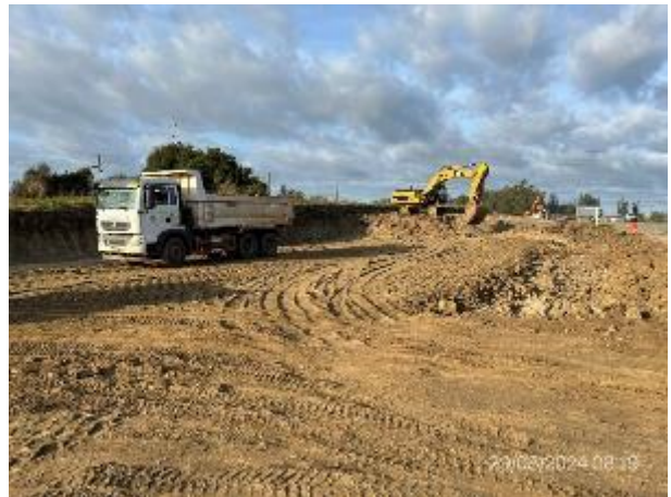
Foto 12.1-4, P07. Frente de obra, apertura de caja y conformación de subrasante.
