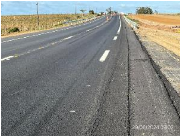
Foto 12.1-9. Ruta 9, nueva carpeta asfáltica terminada, capa superior en mezcla drenante.
