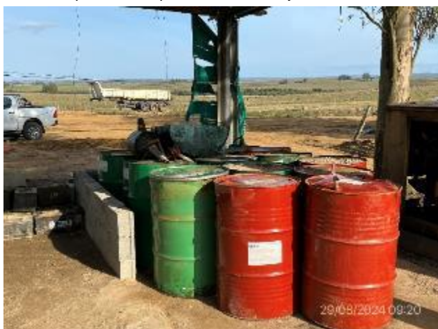
Foto 12.2-11, P03. Campamento provisorio, envallado para tarrinas de lubricantes de superficie insuficiente
