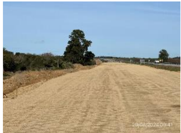
Foto 12.1-6. Ruta 9, tramo con base granular conformada y compactada, sin imprimir.
