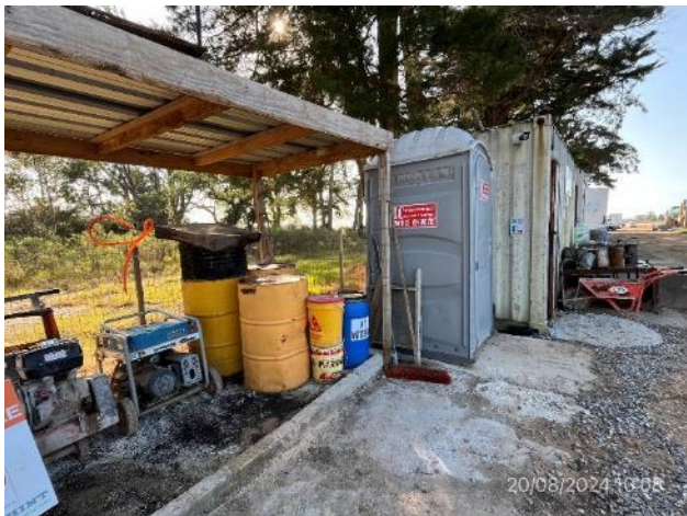
Foto 12.2-9, P02. Campamento provisorio, sector con pavimento impermeable, envallado y techado para alojar tarrinas y bidones de combustibles y lubricantes.
