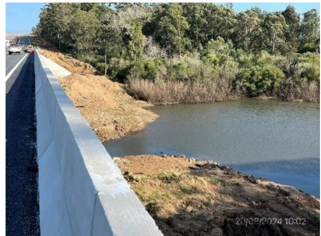
Foto 12.2-4, P02. Puente en obra sobre A° José Ignacio, vigas New Jersey terminadas.
