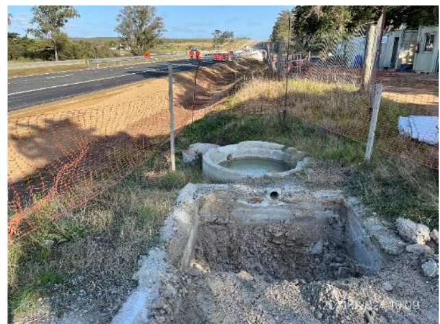
Foto 12.2-12, P02. Campamento provisorio, pileta de lavado elementos en contacto con hormigón.
