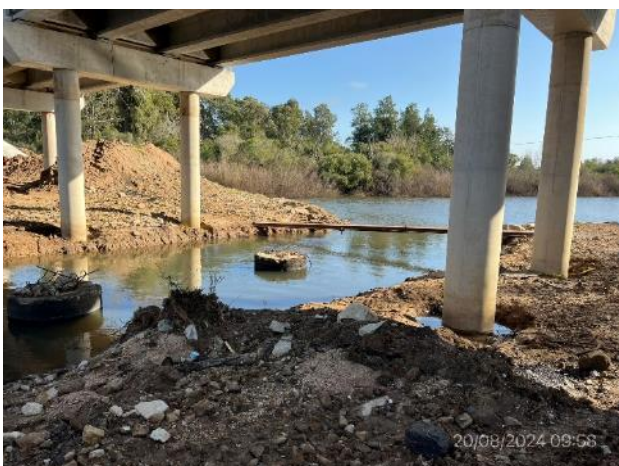
Foto 12.2-5, P02. Puente en obra sobre A° José Ignacio, hay ROCs sin retirar en la planicie de inundación
