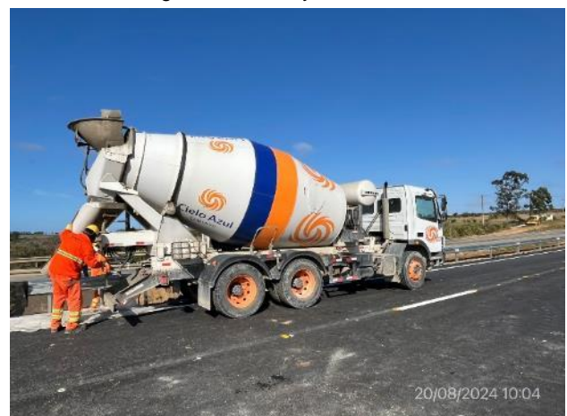
Foto 12.2-6, P02. Puente en obra sobre A° José Ignacio. Frente de obra, colado in situ de hormigón de ¼ de cono.
