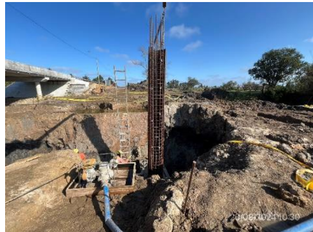
Foto 12.1-2, P01. Ejecución de pilas del nuevo puente.
