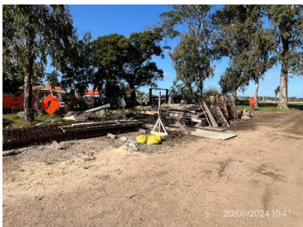
Foto 12.1-11, P04. Explanada granular para estiba de encofrados y armaduras ordenada y limpia.
