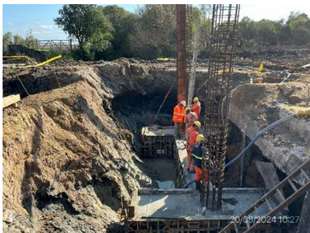
Foto 12.1-5, P01. Ejecución de cimentaciones. Cuadrilla de trabajo en buenas condiciones de orden.
