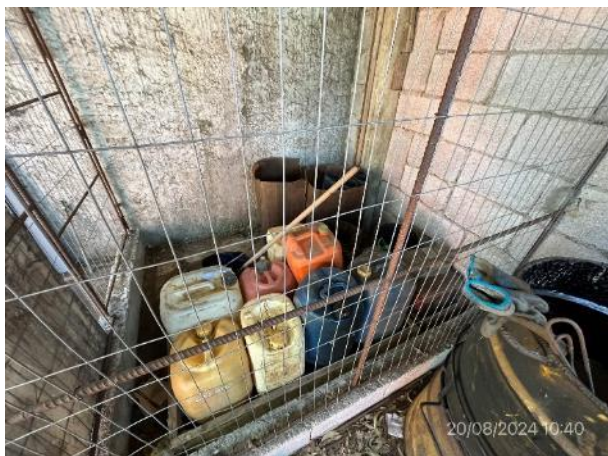
Foto 12.1-9, P04. Campamento provisorio, envallado correcto para acopio de hidrocarburos y KIT para gestión de derrames.
