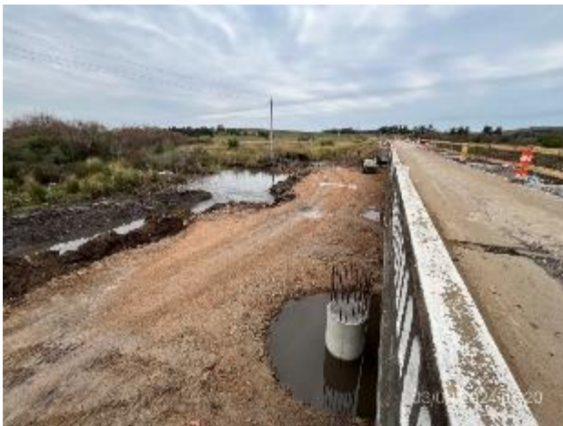
Foto 12.1-3, P01. Pilote construido dentro de ataguía granular.
