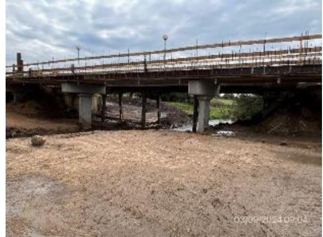
Foto 12.2-2, P02. Tablero en senda a (+) en construcción, vigas New Jersey con armadura en espera.
