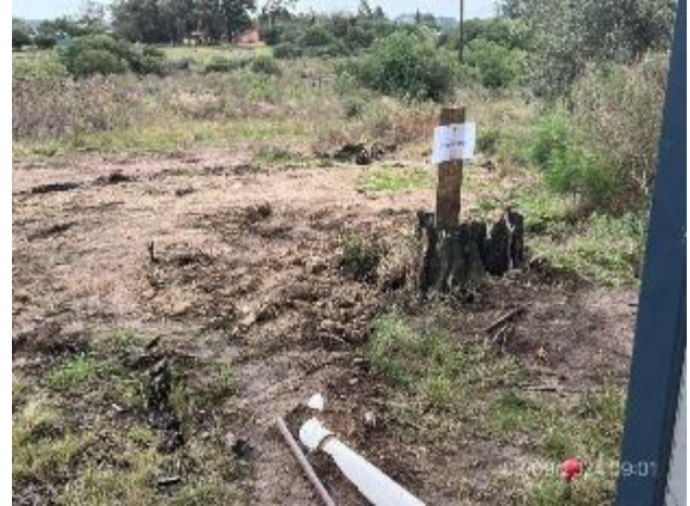
Foto 12.2-8, P02. Campamento provisorio. Depósito impermeable para recolección de aguas servidas.
