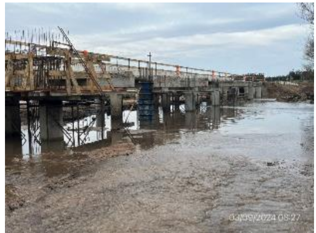
Foto 12.1-4, P01. Vigas dintel superior encofrada. Curso de agua y planicie de inundación limpias sin ROCs.
