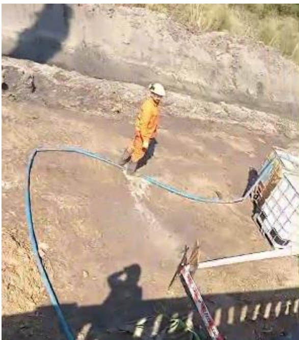
Foto 12.3-3, P01. Bombeo hacia depósito impermeable de aguas mezcladas con lechada de hormigón.
