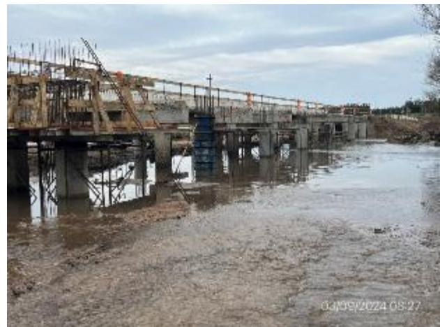
Foto 12.1-8, P01. Trabajos de demolición de tablero por media calzada ejecutados.
