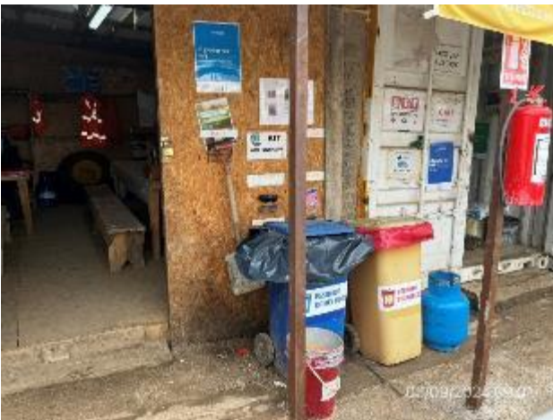
Foto 12.2-9, P02. Campamento provisorio. Estación para acopio temporal de residuos segregados por origen.
