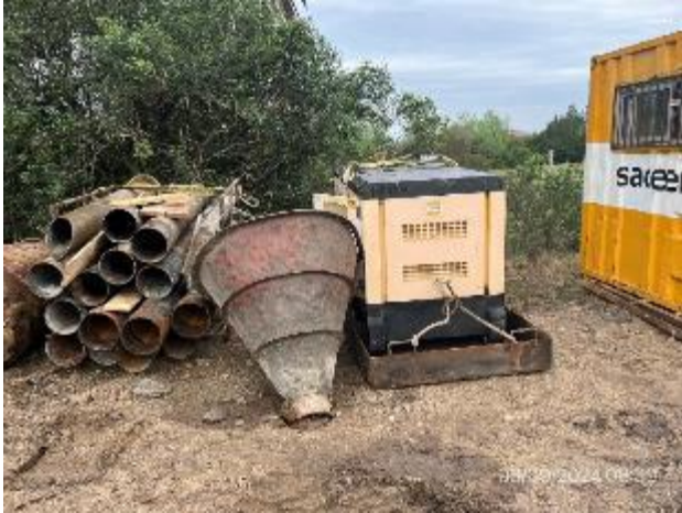
Foto 12.1-11, P01. Grupo electrógeno sobre bandeja estanca. Tubo tremie y embudo limpios.
