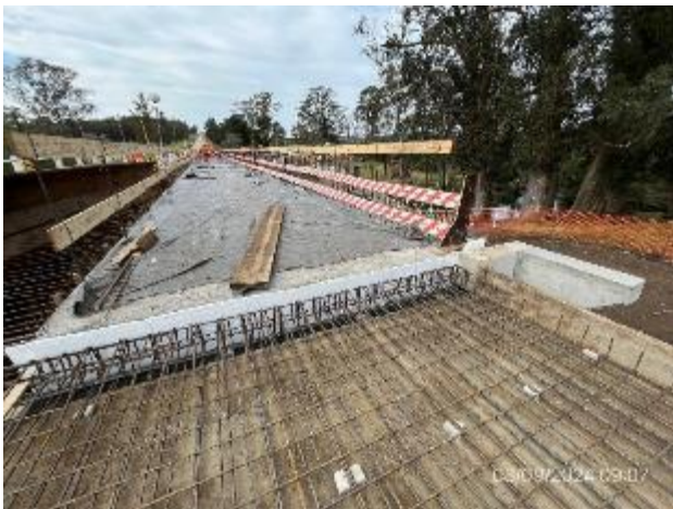
Foto 12.2-3, P02. Tablero superior, tramo con armadura y encofrado listos.
