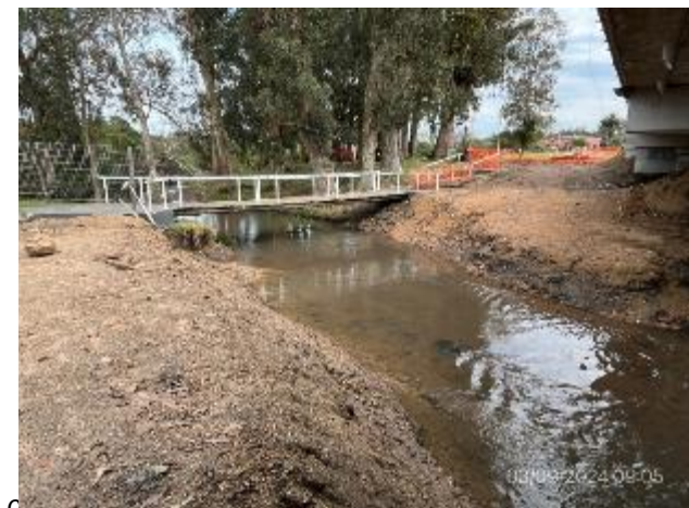
Foto 12.2-6, P02. Curso de agua de A° Pintado limpio, sin ROCs y en buenas condiciones de escurrimiento.
