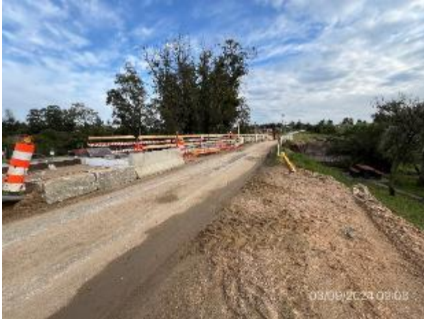
Foto 12.2-1, P02. Puente en obra sobre A° Pintado.
