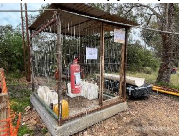
Foto 12.2-11, P02. Campamento provisorio. Recinto techado y envallado para albergar tarrinas y bidones de lubricantes.
