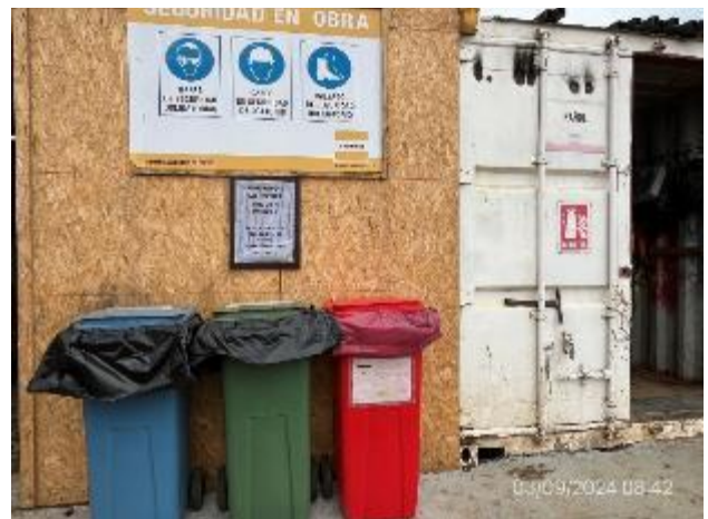
Foto 12.1-16, P01. Tarrinas para acopio temporal de residuos por corriente de generación.
