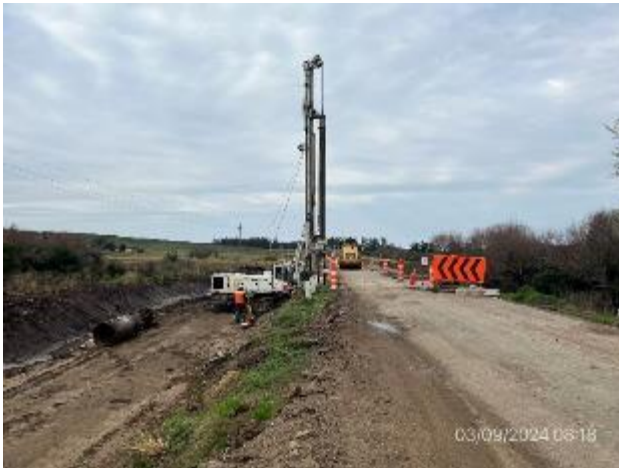
Foto 12.1-1, P01. Puente en obra sobre A° Sarandí, Ruta 12 progresiva 387K100.
