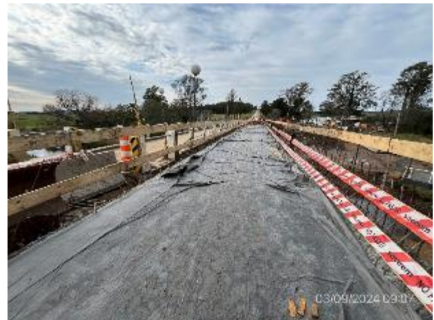
Foto 12.2-4, P02. Tablero superior, tramo en proceso de endurecimiento. Buenas condiciones de limpieza.
