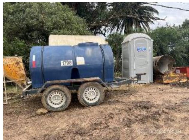
Foto 12.1-10, P01. Depósito de agua no potable.
