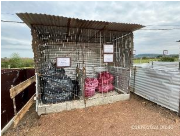
Foto 12.1-13, P01. Local techado con acopio de residuos domésticos y peligrosos segregados.
