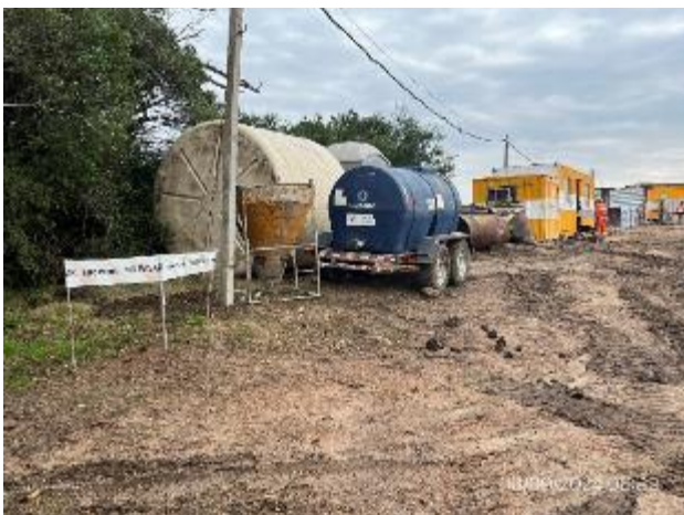
Foto 12.1-9, P01. Obrador A° Sarandí, Cabecera Sur. Ruta 12 progresiva 387K100 a (+).
