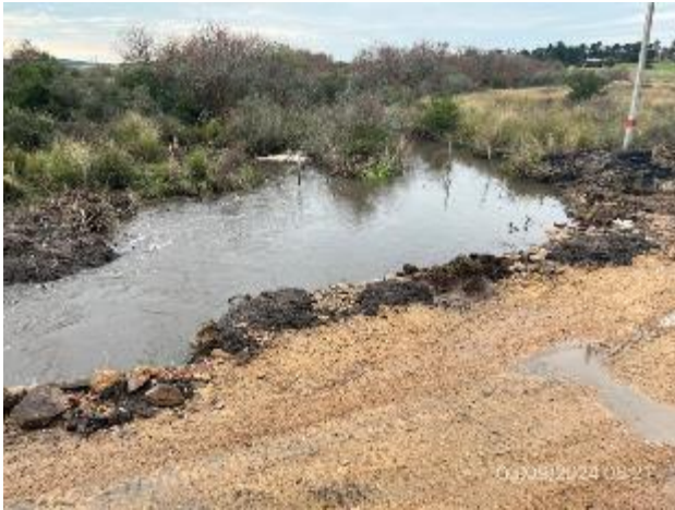
Foto 12.1-5, P01. Ataguía granular, A° Sarandí entubado con velocidad de escurrimiento correcta.
