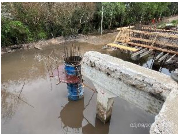
Foto 12.1-7, P01. Pilar encofrado con armadura colocada.
