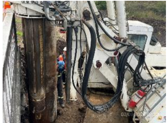
Foto 12.1-2, P01. Tarea en ejecución de excavación de pilote perforado encamisado.
