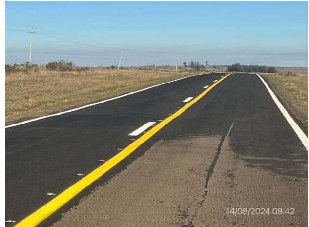
Foto 12.1-2, P02. Fin de tramo, Ruta 31, progresiva 94K000.
