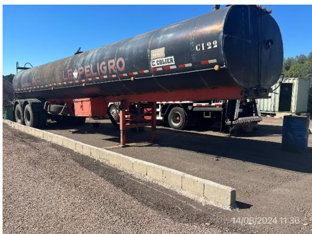
Foto 12.1-9, P03. Obrador, cisterna móvil de emulsión asfáltica con envallado perimetral para contención de derrames.
