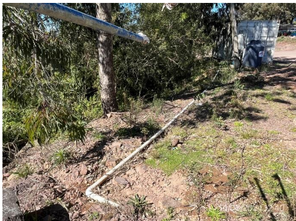
Foto 12.1-21, P04. Se conectó caño de desagüe a depósito impermeable
