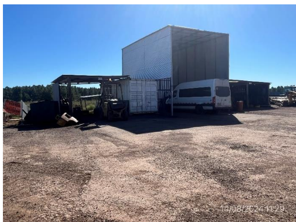
Foto 12.1-5, P03. Obrador, taller mecánico techado con explanada de trabajo impermeable.
