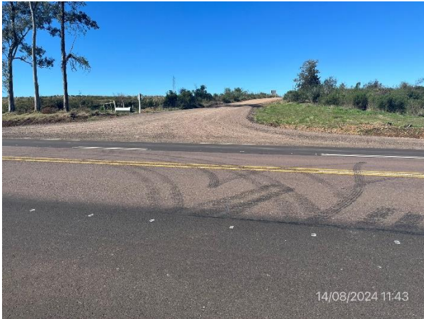
Foto 12.2-1, P05. Terceras sendas terminadas en Cuchilla de la Palma. Ruta 5, progresiva 413K600.
