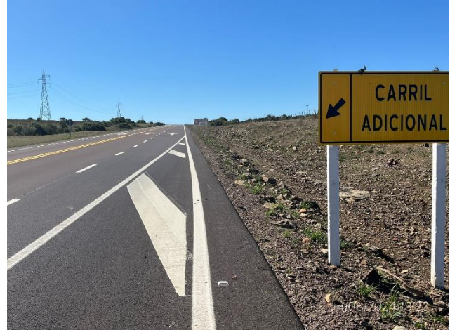
Foto 12.2-8, P07. Tercera vía abierta al tránsito y con señalización horizontal y vertical terminadas.
