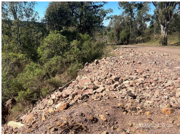
Foto 12.1-19, P04. Se protegió borde del talud perimetral del obrador con grava para la prevención de erosiones.
