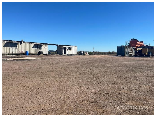
Foto 12.1-1, P03. Obrador y planta asfáltica. Padrón 11586 5ª SC de Tacuarembó, Ruta 5 progresiva 416K500.
