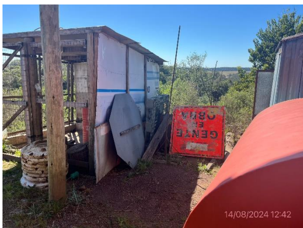
Foto 12.1-23, P04. Zona de obradores de subcontratistas en buenas condiciones de orden y limpieza.
