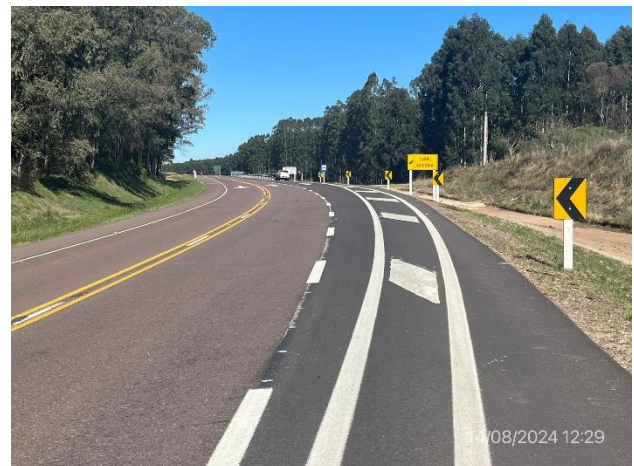
Foto 12.2-4, P06. Terceras sendas terminadas en Ruta 5, progresiva 371K600.
