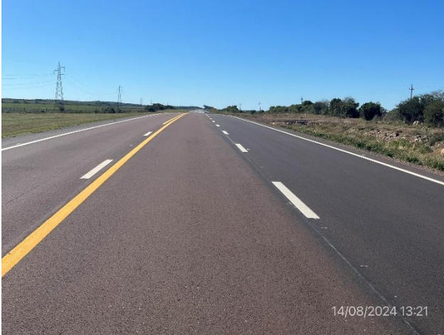
Foto 12.2-7, P07. Terceras sendas terminadas en Ruta 5, progresiva 343K000
