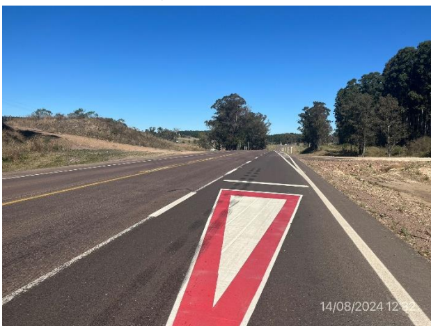
Foto 12.2-5, P06. Tercera vía abierta al tránsito y con señalización horizontal terminada.
