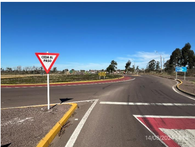
Foto 12.2-11, P08. Nueva rotonda abierta al tránsito y con señalización horizontal y vertical terminadas.
