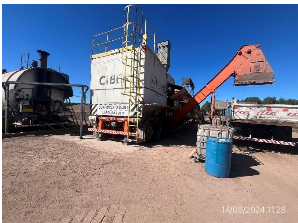
Foto 12.1-3, P03. Planta asfáltica, explanada ordenada y en buenas condiciones de limpieza.
