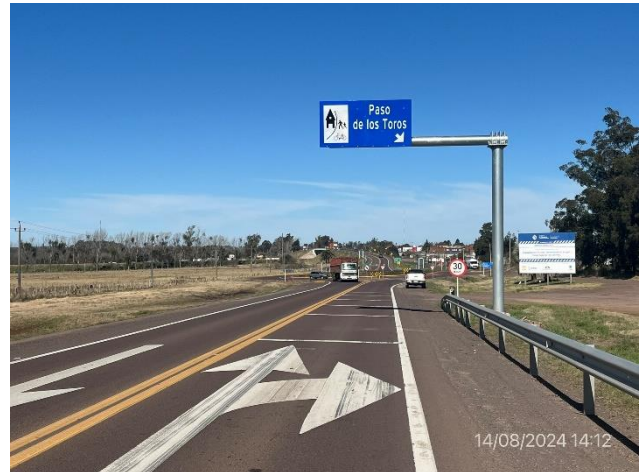
Foto 12.2-10, P08. Nueva rotonda de acceso Norte a Paso de los Toros. Ruta 5, progresiva 250K900.
