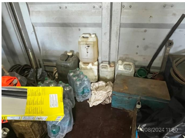
Foto 12.1-7, P03. Obrador, pañol. Hay bidones con lubricantes y combustibles sin elementos de contención para prevención de posibles derrames.
