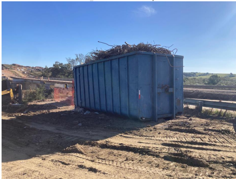
Ilustración 6: Volqueta utilizada para la chatarra de demolición.
