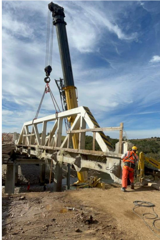
Ilustración 11: Demolición del puente.
