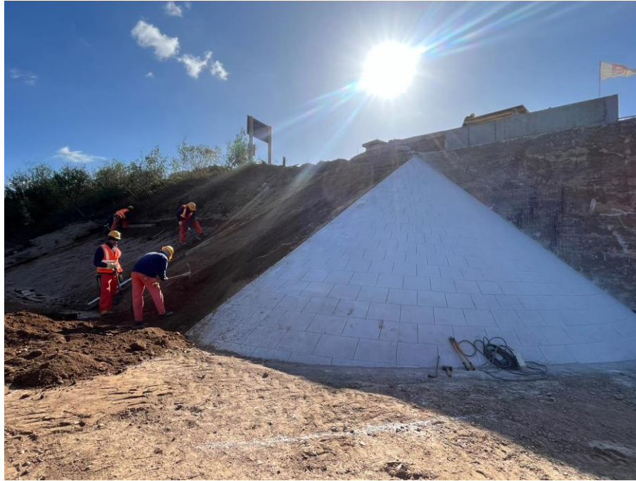
Ilustración 9: Ejecución del cuarto de cono del puente.
