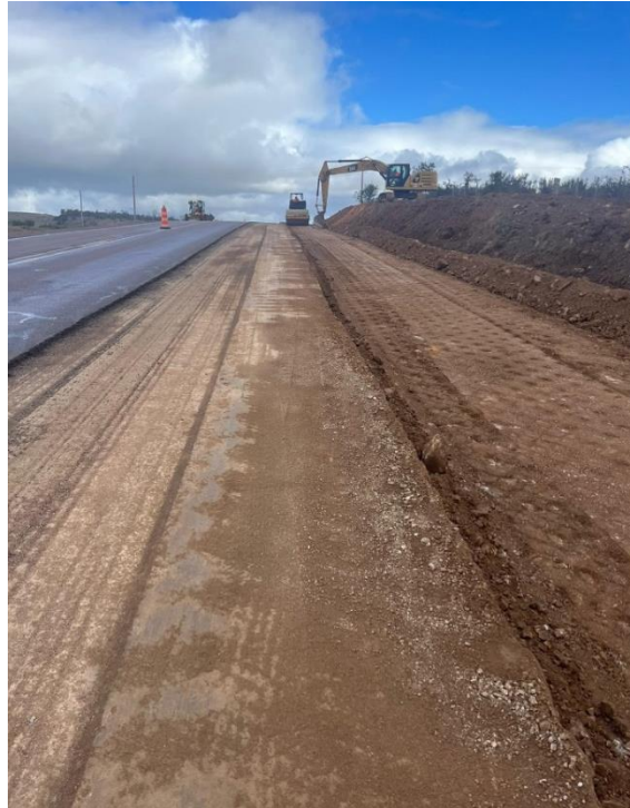
Ilustración 10: Ensanche del tercer carril en lado norte del puente.
