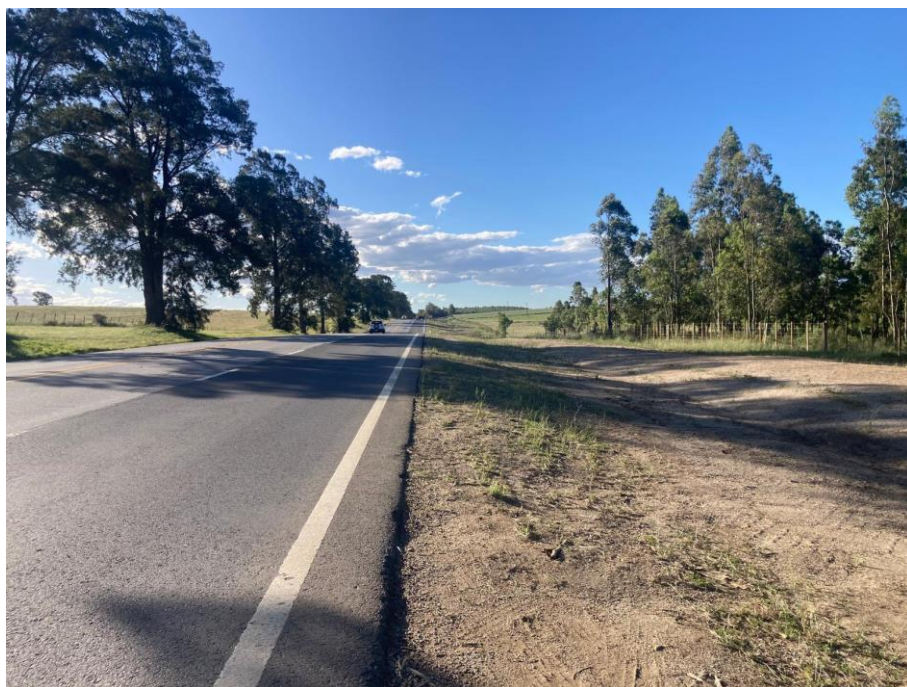
Situación final Ensanche 6 (foto tomada el 12/11/2024).
