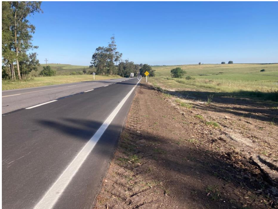
Situación final Ensanche 7 (foto tomada el 12/11/2024).
