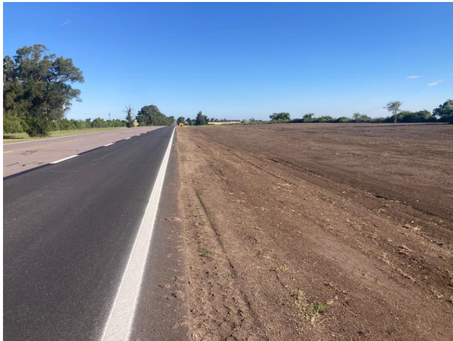
Situación final Ensanche 9 (foto tomada el 12/11/2024).
