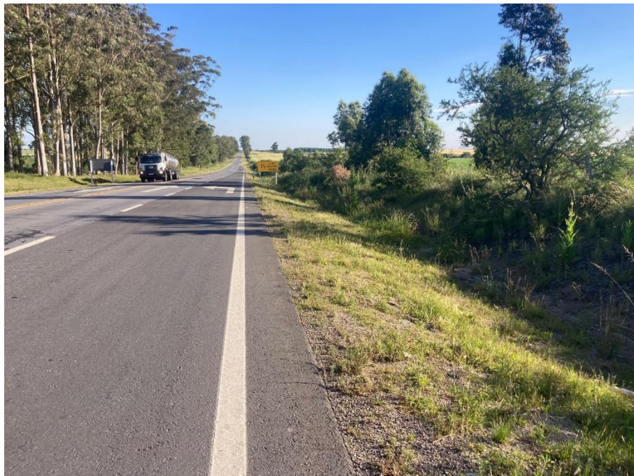
Situación final Ensanche 4 (foto tomada el 12/11/2024).
