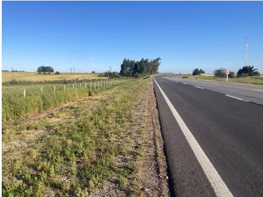
Situación final Ensanche 3 (foto tomada el 12/11/2024).
