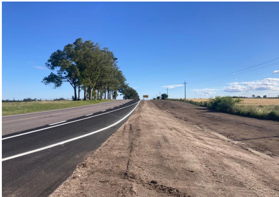
Situación final Ensanche 11 (foto tomada el 12/11/2024).
