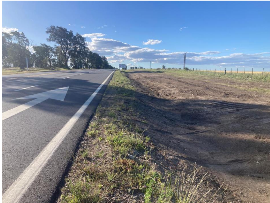
Situación final Ensanche 5 (foto tomada el 12/11/2024).
