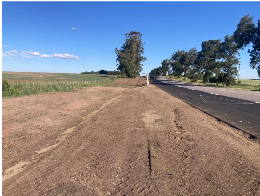
Situación final Ensanche 10 (foto tomada el 12/11/2024).
