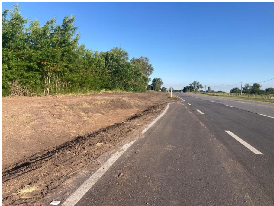
Situación final Ensanche 2 (foto tomada el 12/11/2024).
