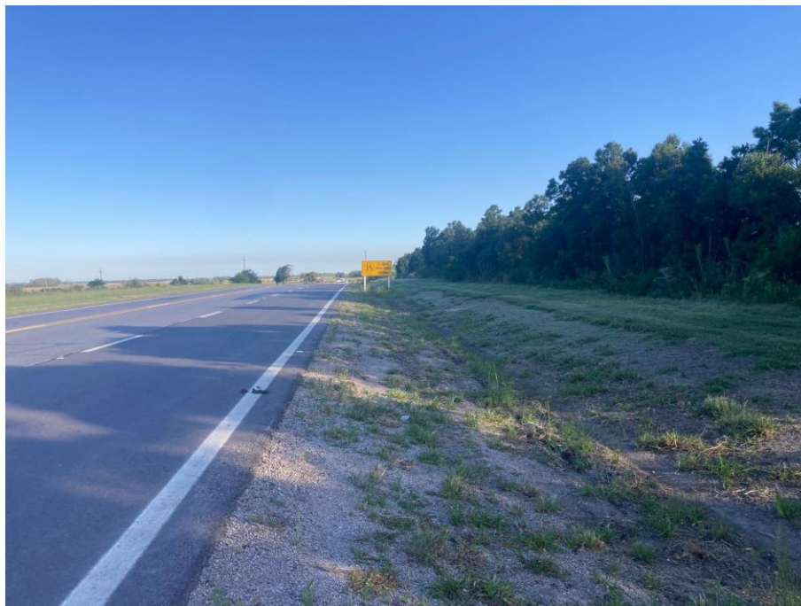
Situación final Ensanche 1 (foto tomada el 12/11/2024).
