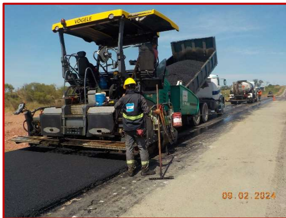
Extendido y compactación de la mezcla asfáltica sobre base cementada.
