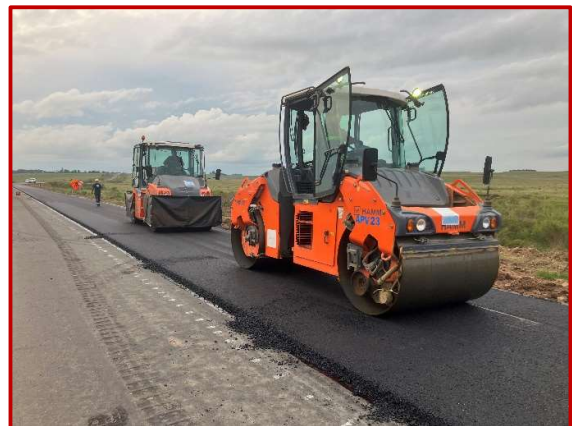
Extendido y compactación de la mezcla asfáltica sobre base cementada.
