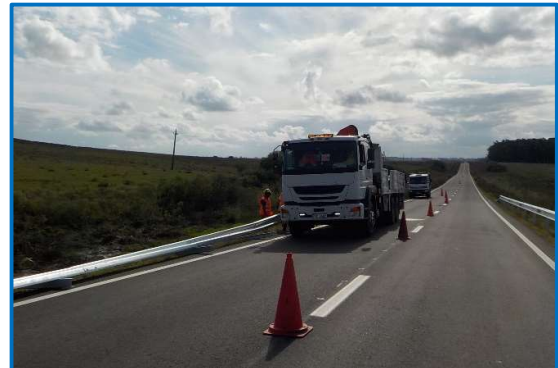
Retiro de señalización existente e instalación de barreras metálicas.
