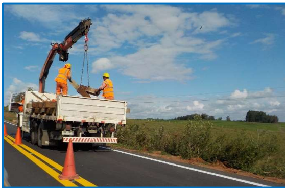
Retiro de señalización existente e instalación de barreras metálicas.
