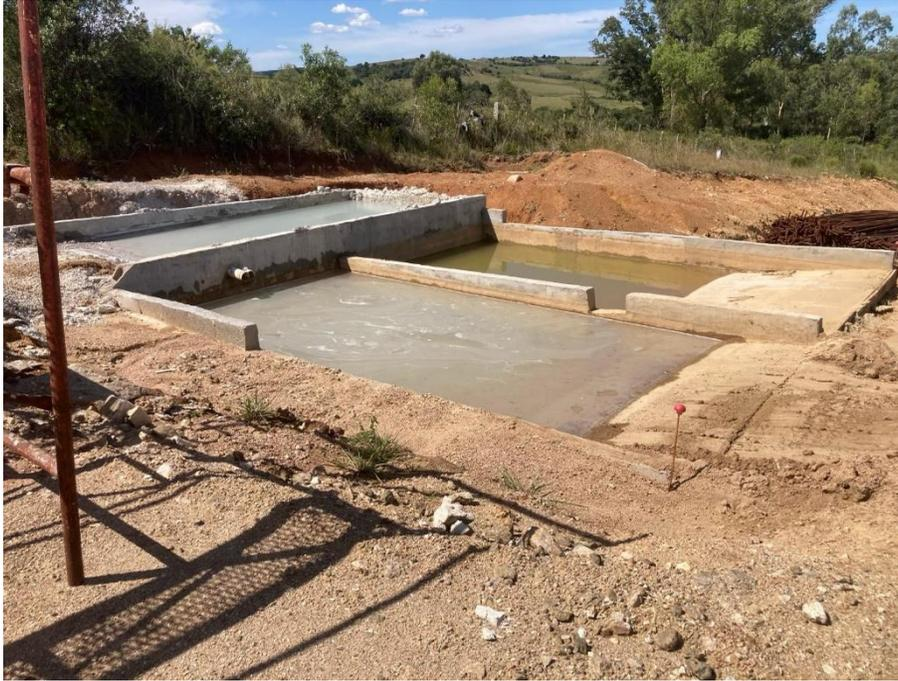
*Ilustración 3: Piletas de lavado de mixers.*
