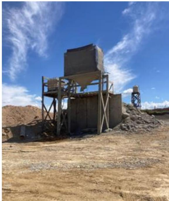
*Ilustración 4: Tolva de hormigón con malla de para disminuir las emisiones al aire.*
