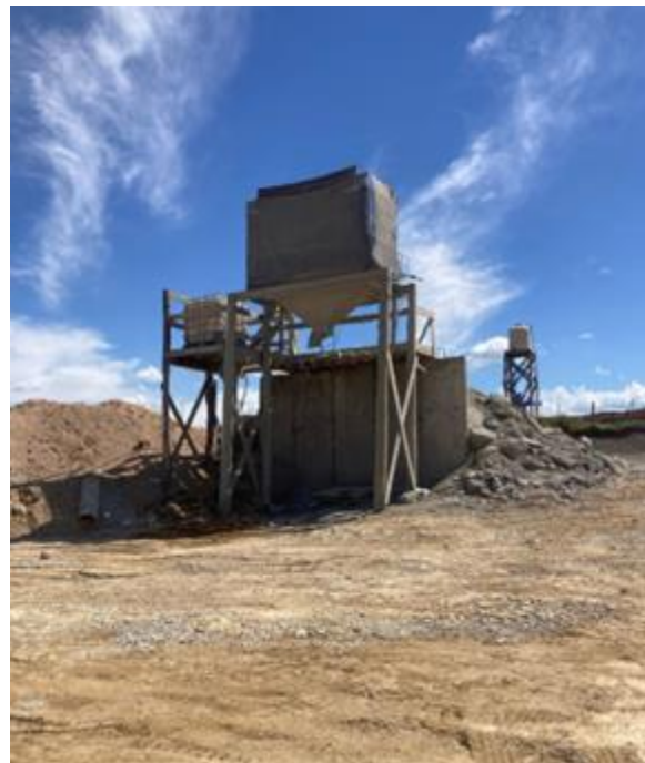
Ilustración 4: Tolva de hormigón con malla de para disminuir las emisiones al aire.
