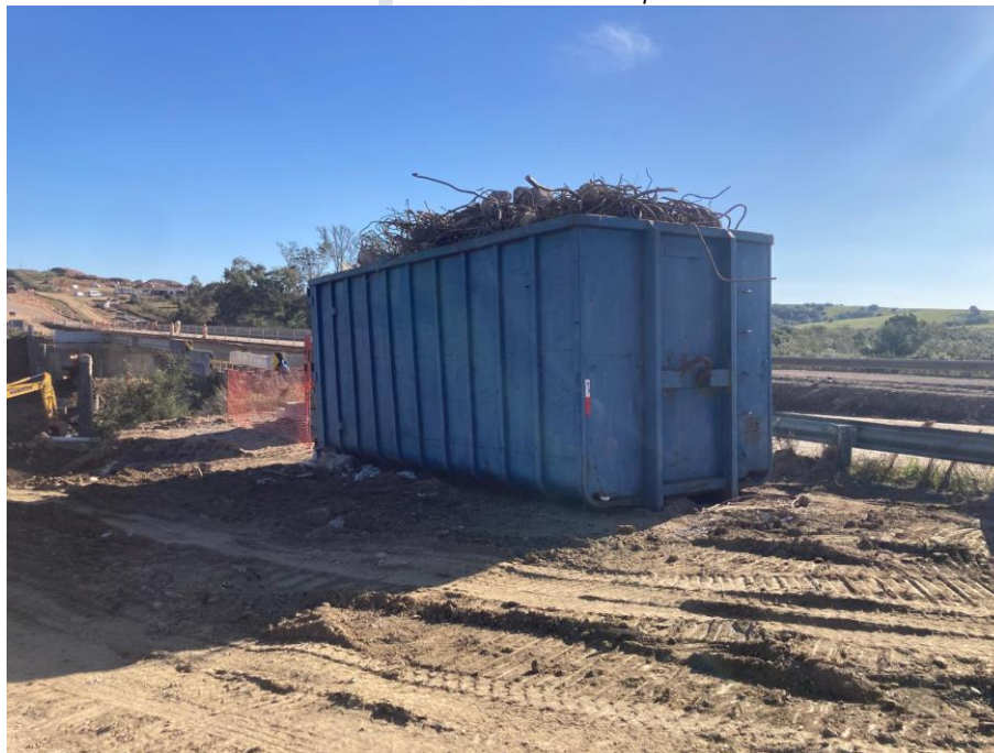
Ilustración 6: Volqueta utilizada para la chatarra de demolición.
