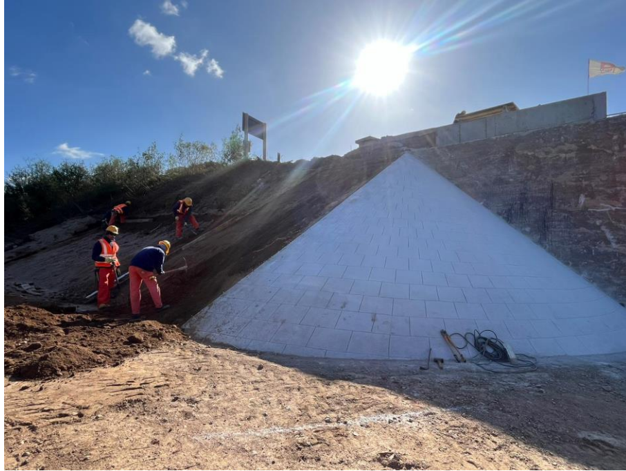
Ilustración 9: Ejecución del cuarto de cono del puente.
