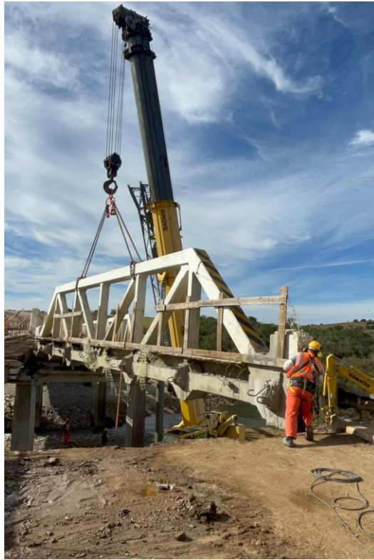
Ilustración 11: Demolición del puente.
