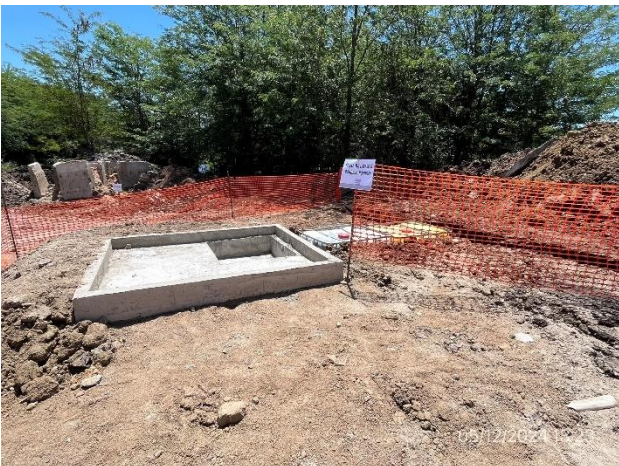
Foto 12.2-11, P02. Pileta de lavado de camiones mixer, de construcción reciente.
