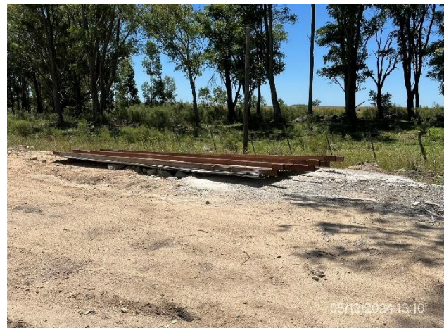
Foto 12.1-6, P01. Obrador, pileta de lavado de camiones mixer demolida y rellena.
