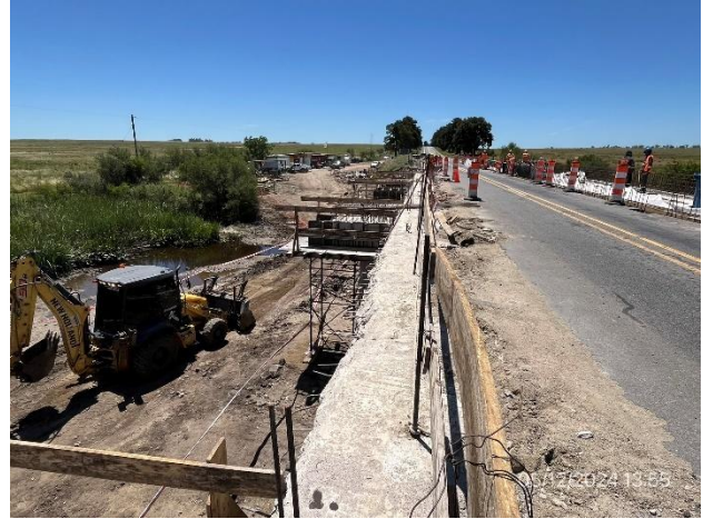
Foto 12.3-2, P03. Ataguía granular ejecutada en lecho del curso de agua.
