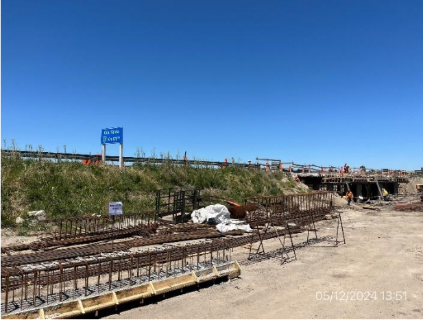
Foto 12.3-1, P03. Puente en obra sobre A° Sarandí. Ruta 3 progresiva 194K180.
