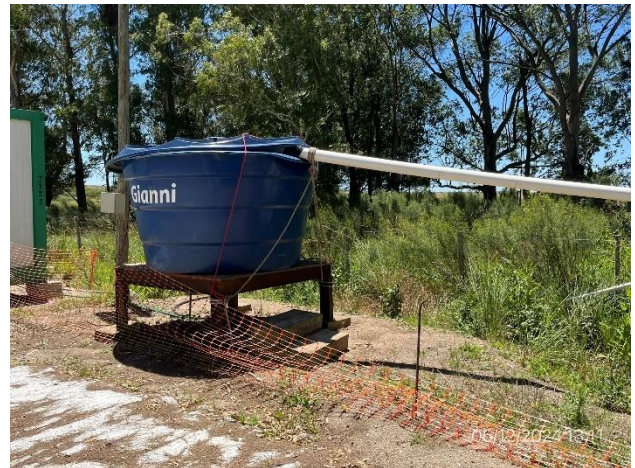
Foto 12.1-10, P01. Obrador, reservorio de agua no potable pendiente de ser removido.
