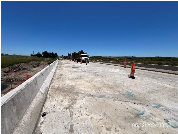
Foto 12.1-3, P01. Puente abierto al tránsito en media calzada.
