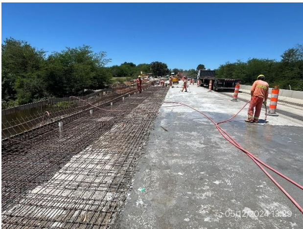
Foto 12.2-3, P02. Ejecución de ensanche en tablero.
