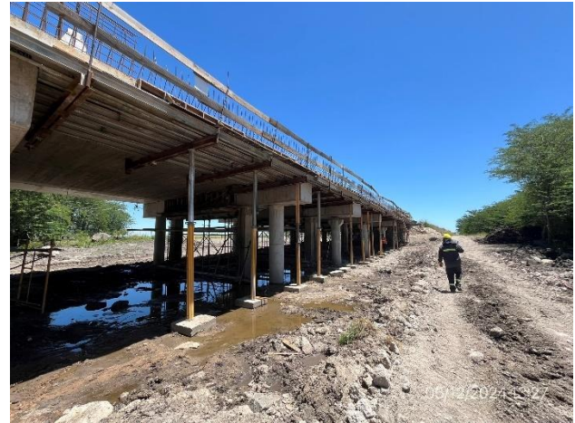
Foto 12.2-2, P02. Atagüía granular ejecutada en lecho del curso de agua.
