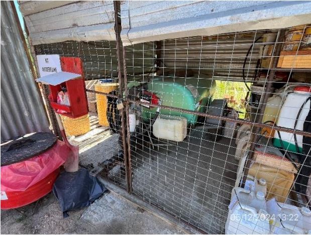
Foto 12.2-7, P02. Recinto cerrado y envallado con pavimento impermeable para alojar tarrinas con combustible y productos químicos.
