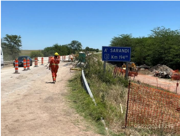
Foto 12.2-1, P02. Puente en obra sobre A° Sarandí. Ruta 3 progresiva 194K180.
