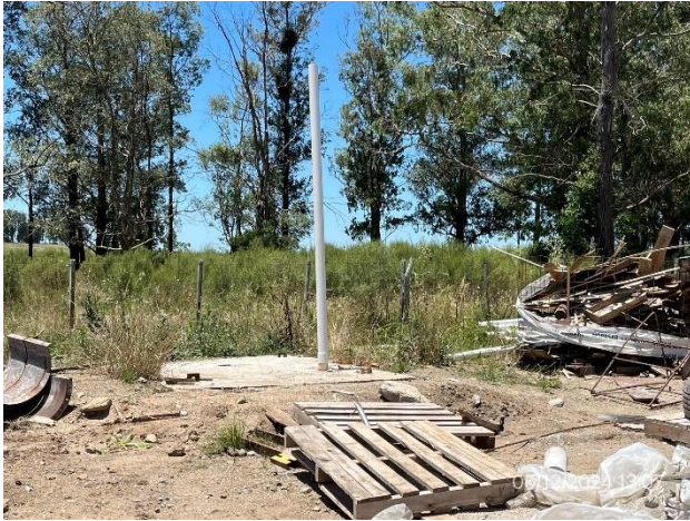
Foto 12.1-7, P01. Obrador, depósito impermeable aún sin ser desmantelado
