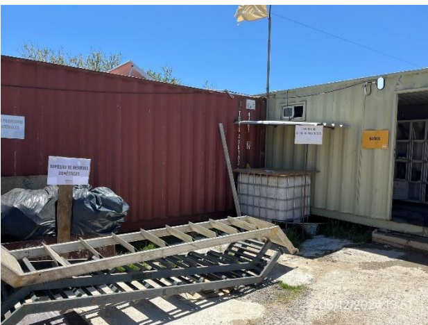
Foto 12.3-5, P03. Campamento provisional de SACEEM. Buenas condiciones de orden y limpieza.
