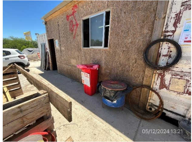
Foto 12.2-8, P02. Infraestructura correcta para acopio temporal de residuos segregados por corriente de generación.
