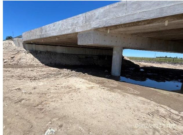
Foto 12.1-2, P01. Obra en hormigón terminada.
