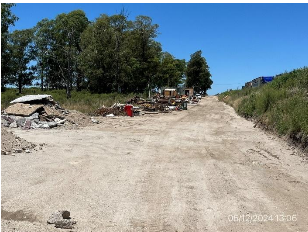
Foto 12.1-5, P01. Obrador en proceso de desmontaje.
