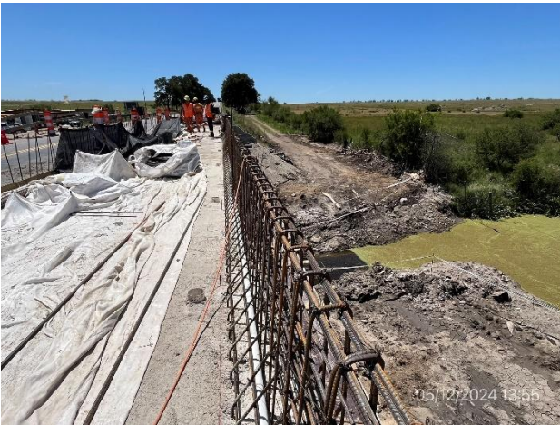
Foto 12.3-3, P03. Ejecución de ensanche en tablero.
