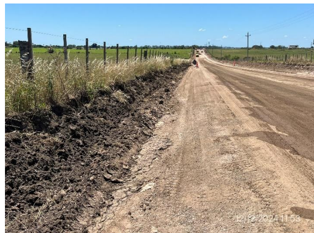
Foto 12.1-4, Ruta 76, tramo con ancho insuficiente para correcta conformación de taludes.
