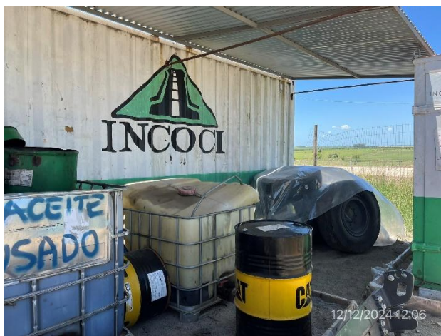
Foto 12.2-5, P03. Obrador, depósito envaseado y techado para acopio de lubricantes usados
