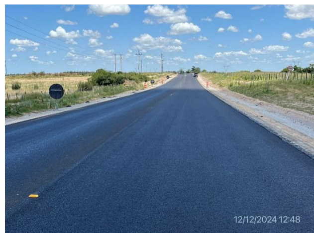
Foto 12.1-4, Ruta 76, tramo con ancho insuficiente para correcta conformación de taludes.
