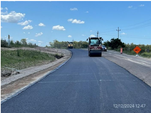
Foto 12.1-9, P07. Frente de obras, compactación y perfilado de carpeta de rodadura en ejecución.
