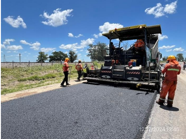
Foto 12.1-7, P07. Ruta 77 progresiva 10K300. Frente de obras, tendido de mezcla asfáltica en ejecución.
