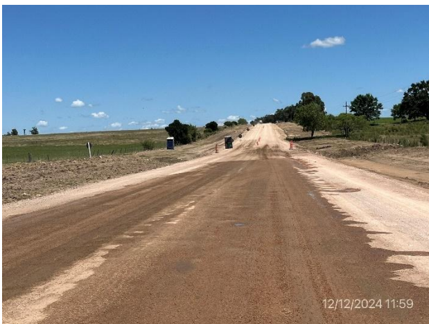
Foto 12.1-3, Ruta 76, tramo con base granular cementada en calzada completa y banquetas.
