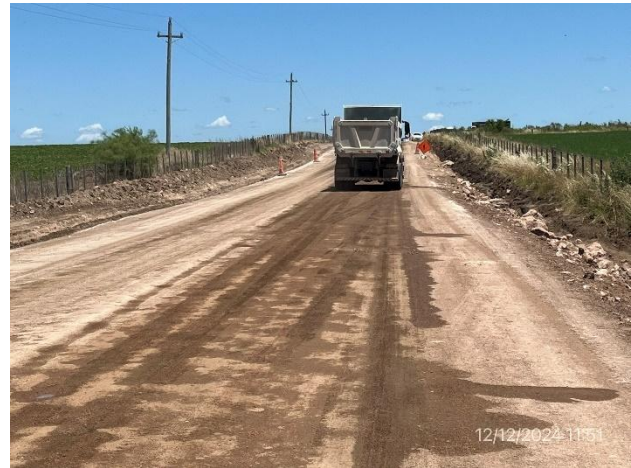
Foto 12.1-2. P08, cementado de base granular en ejecución.
