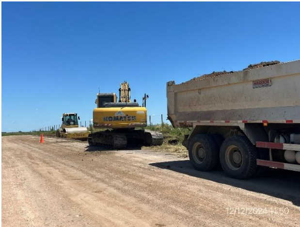
Foto 12.1-1, P08. Frente de obra de movimiento de suelos y recargo granular. Ruta 76 progresiva 2K400.
