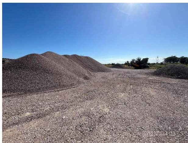
Foto 12.1-2, P05. Cantera, acopios de material triturado al servicio de las obras del Consorcio.
