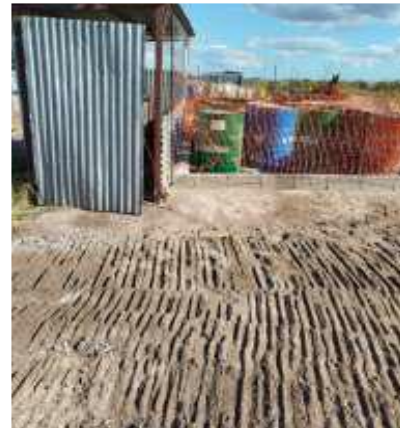
Foto 12.4-2, P05. Se retiraron los suelos contaminados con hidrocarburos.
