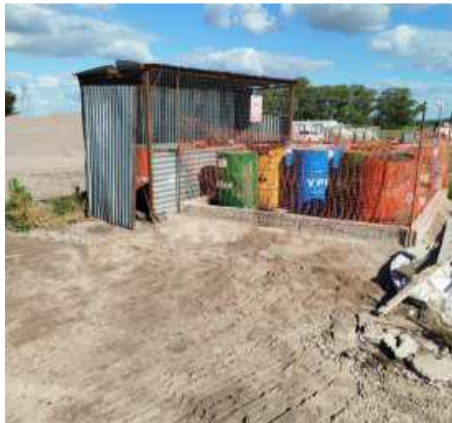
Foto 12.4-1, P05. Se colocaron los tanques con hidrocarburos en recinto cercado y envallado.
