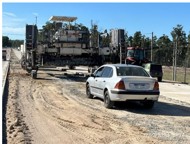
Foto 12.2-6, P16. Frente de obras de LPPSA, tendido de carpeta de rodadura en hormigón.
