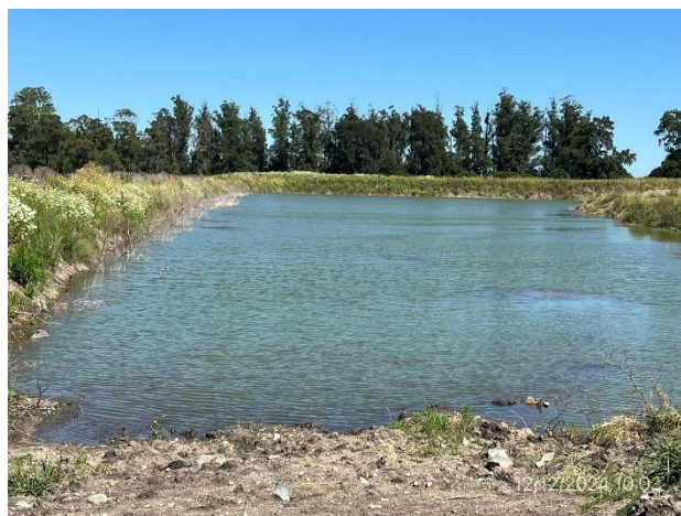
Foto 12.2-4, P11. Excavación queda como tajamar, como beneficio a futuro para propietario del predio.
