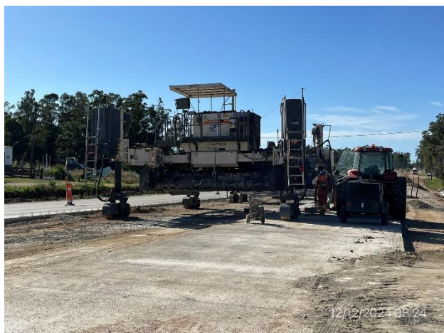
Foto 12.2-5, P16. Frente de obras de LPPSA. Ruta 5 progresiva 94K200.
