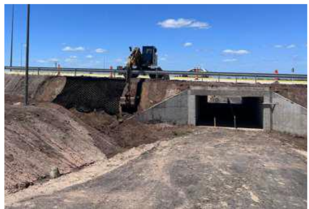
Foto 12.5-6, P08. Se cubrió la geogrilla con tierra negra para favorecer el crecimiento del tapiz vegetal.
