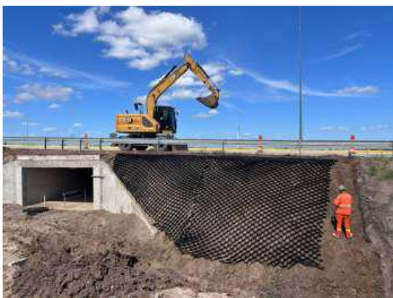
Foto 12.5-5, P08. Se suavizaron los taludes y se colocó geogrilla
