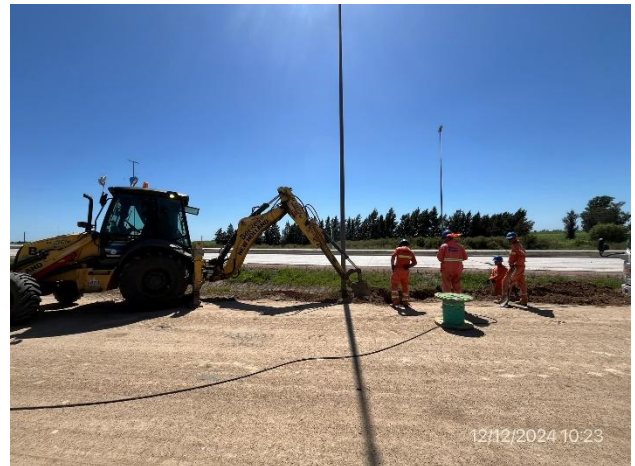
Foto 12.1-16, P07. Ruta 5 progresiva 78K800, frente de obras, Berkes Eléctrica. Buenas condiciones de orden y limpieza.
