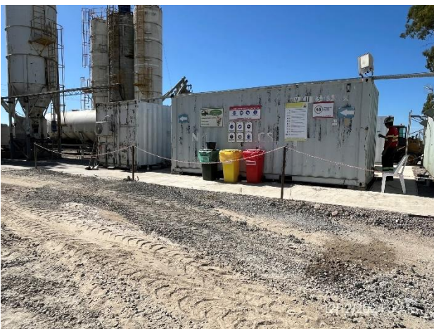
Foto 12.2-5, P03. Planta de hormigón, estación para acopio temporal de residuos segregados por origen.
