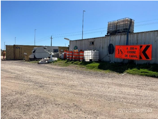
Foto 12.3-1, P06. Obrador de R&K Ingenieros SA. Padrón rural N° 17875 de la 5ª S.C. de Florida. Ruta 5 progresiva 84K600 a (-).
