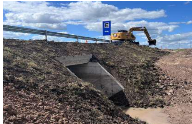
Foto 12.5-8, P11. Se cubrieron los taludes reconformados con tierra vegetal para favorecer el empastado.
