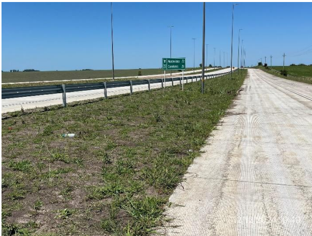
Foto 12.1-3, Ruta 5. Empastado de taludes en correcto
