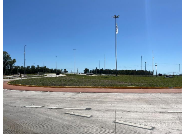
Foto 12.1-2, Ruta 5. Tramo duplicado en rotonda con pavimento en hormigón y obras de iluminación terminadas.
