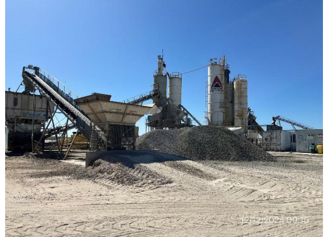
Foto 12.2-2. P03, Planta de hormigón, explanada de maniobras en buenas condiciones de orden y limpieza.
