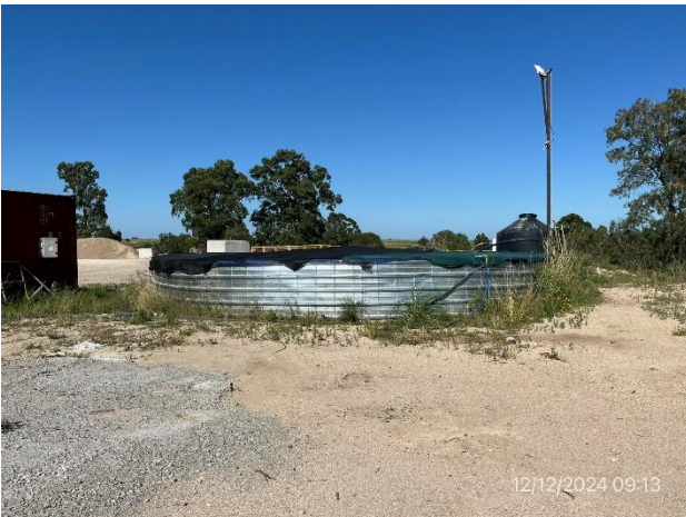
Foto 12.2-3, P03. Tanque australiano para contención de agua de pozo para planta de hormigón.
