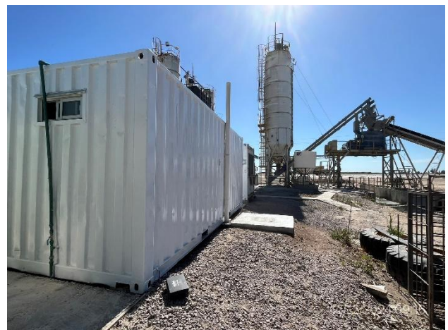
Foto 12.2-6, P03. Planta de hormigón, depósito para contención de aguas servidas.
