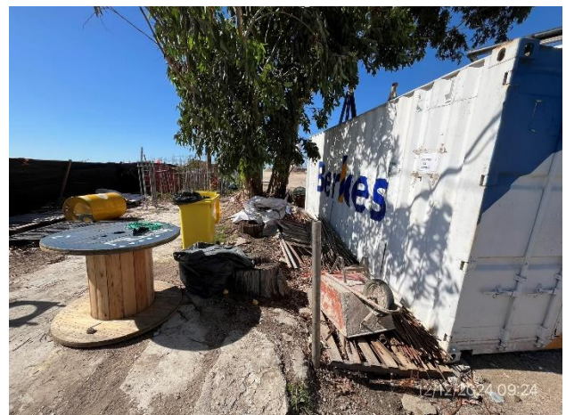
Foto 12.2-12, P03. Obrador Berkes eléctrica, infraestructura precaria para acopio de residuos.
