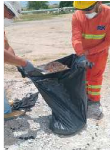
Foto 12.5-4, P06. El suelo con emulsión fue a disposición final, tratado como residuo contaminado.
