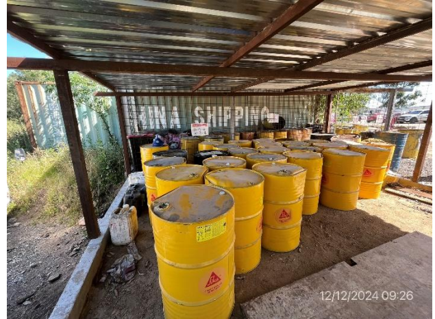
Foto 12.2-8, P03. Obrador Consorcio, acopio de tarrinas de lubricantes en local techado y envallado.
