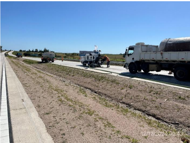
Foto 12.1-15, P09. Ruta 5 progresiva 86K300 Trabajos de regularización de superficie para mejora de IRI.
