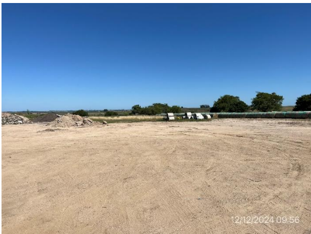
Foto 12.3-5, P06. Explanada de maniobras, buenas condiciones de orden y drenaje adecuado
