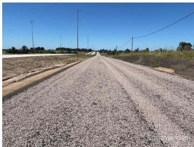
Foto 12.1-10, Ruta 5, calle secundaria de acceso a Mendoza Chico. Pavimento en tratamiento bituminoso ejecutado
