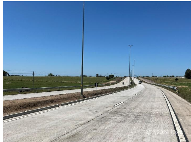
Foto 12.1-4, Ruta 5. Tramo duplicado con pavimento en hormigón y obras de iluminación y señalización terminadas.
