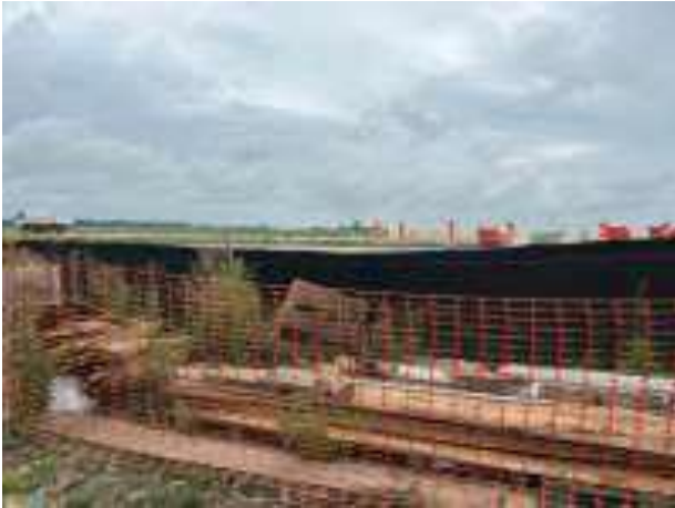
Foto 12.5-1, P03. Se colocaron delimitaciones para mejorar el orden de la zona del obrador de Berkes Eléctrica.
