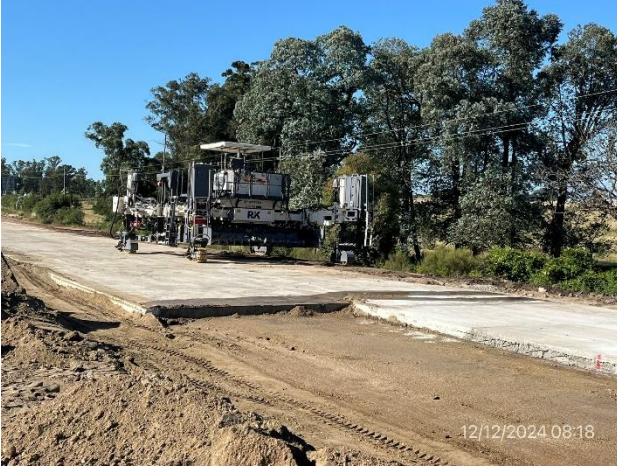
Foto 12.1-13, P10. Ruta 5 progresiva 93K100. Frente de obras de R&K Ingenieros SA.
