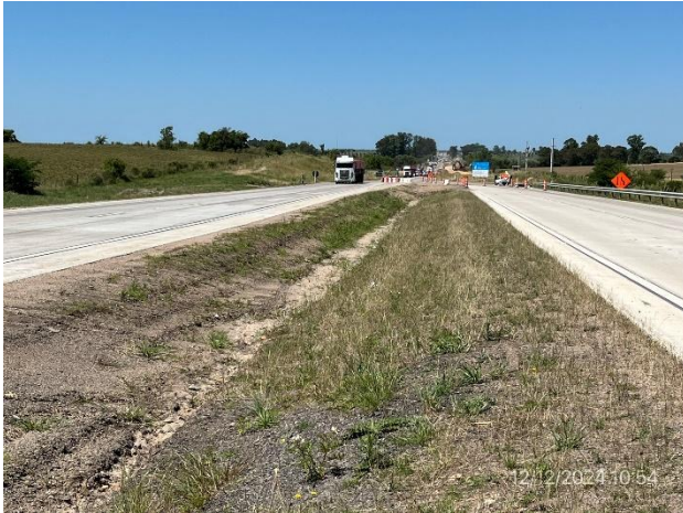
Foto 12.1-1, P01. Inicio de tramo. Ruta 5 progresiva 69K000.
