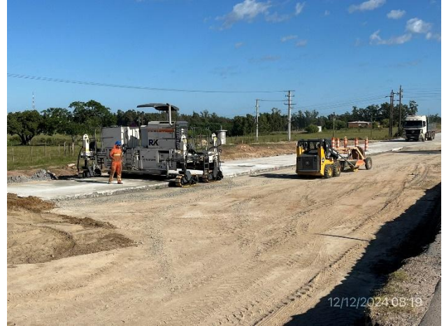
Foto 12.1-14, P10. Tendido de pavimento en hormigón, senda a (-).
