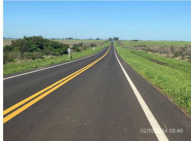
Foto 12.1-2. Obras terminadas en Ruta 26. Carpeta de rodadura y señalización horizontal terminadas.
