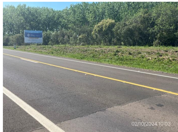
Foto 12.1-6, P01. Inicio de tramo, Ruta 26 progresiva 70K000.
