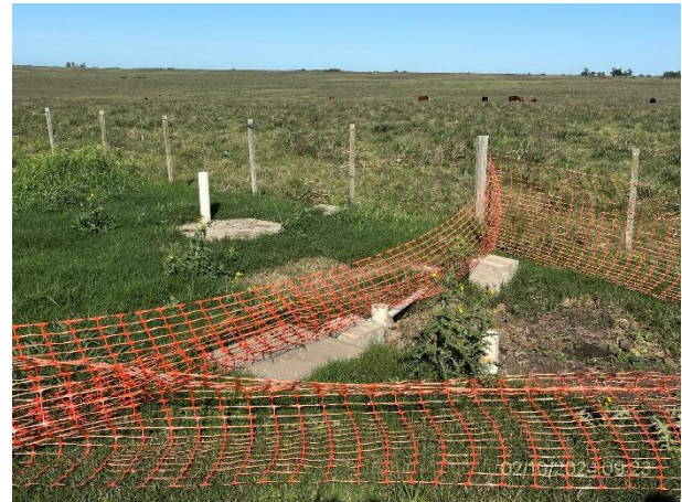
Foto 12.2-2, P03. Depósito impermeable de aguas cloacales.
