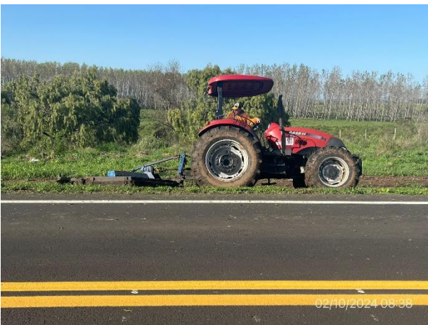
Foto 12.1-3, P04. Ruta 26 progresiva 111K800. Mantenimiento de áreas verdes en ejecución.
