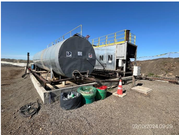
Foto 12.2-9, P03. Planta asfáltica. Estación para gestión temporal de residuos correcta y apegada al PGA.
