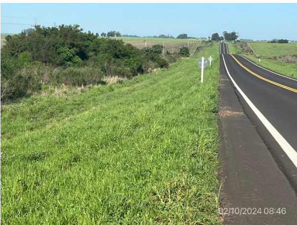
Foto 12.1-5. Obras terminadas en Ruta 26. Faja pública en buenas condiciones de drenaje y tapiz vegetal.
