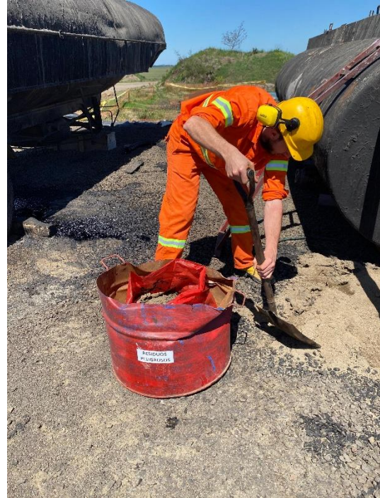
Foto 12.3-2, P03. Explanada de estacionamiento de cisternas de emulsión. Tarea de remoción de residuos oleosos en ejecución.
