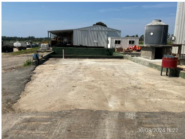
Foto 12.1-7, P05. Explanada de lavado de camiones, buenas condiciones de limpieza.
