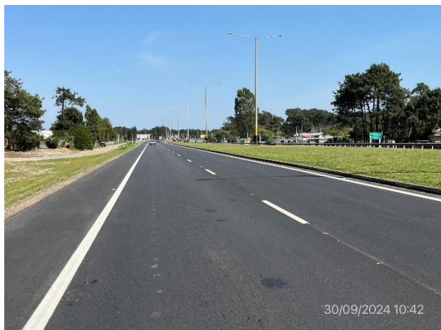
Foto 12.2-3. Ruta Interbalnearia. Nueva obra de recapado terminada, tramo abierto al tránsito.
