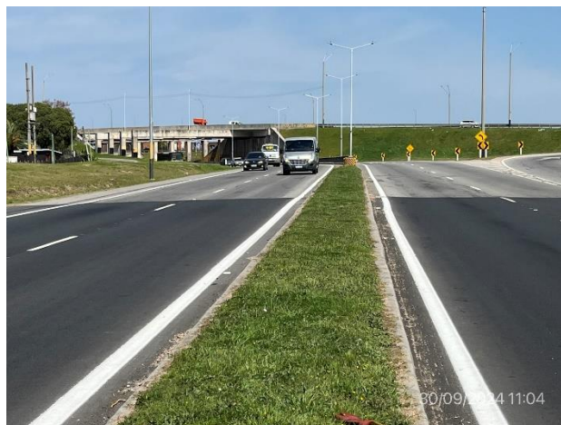
Foto 12.2-6, P01. Inicio del tramo, construcción por parte de CVC SA. Ruta Interbalnearia progresiva 22K900.
