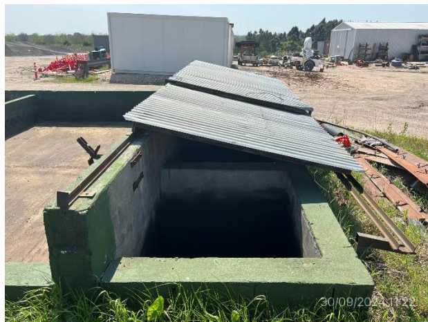
Foto 12.1-8, P05. Explanada de lavado de camiones, pendientes adecuadas hacia decantador de grasas y aceites.
