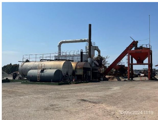
Foto 12.1-10, P05. Planta asfáltica, no hay operación al momento de la auditoría.
