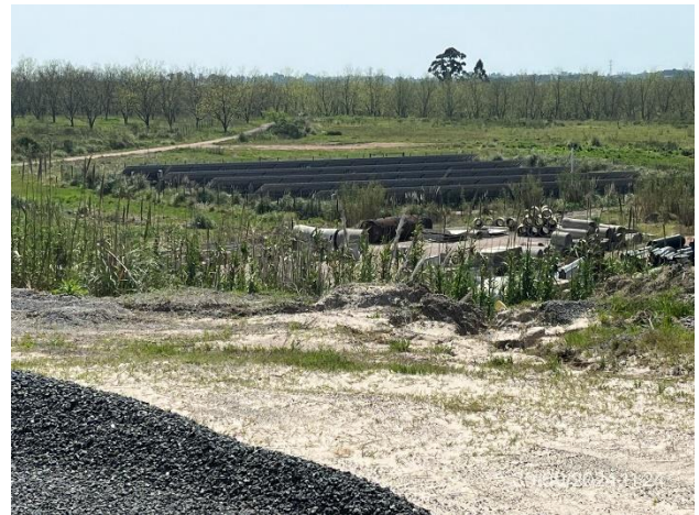
Foto 12.1-2, P05. Planta fotovoltaica de producción de energía eléctrica.
