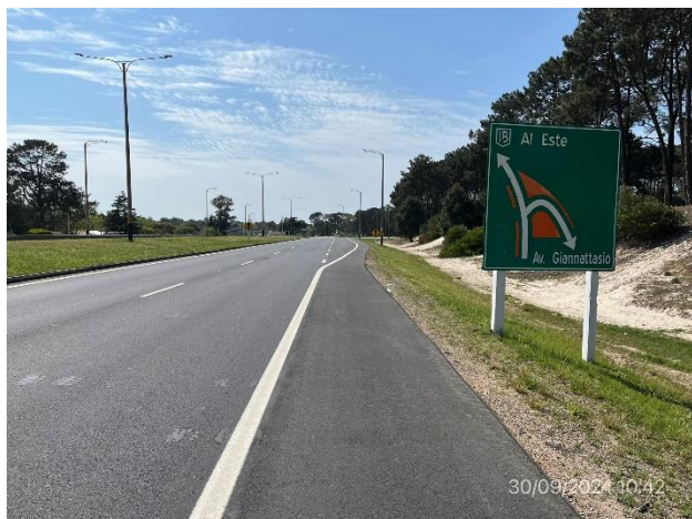
Foto 12.2-1, P02. Fin del tramo, construcción por parte de Molinsur SA. Ruta Interbalnearia progresiva 33K300, A° Pando.
