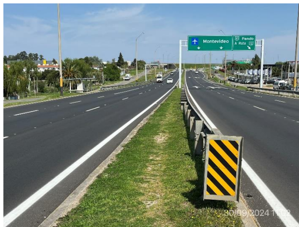
Foto 12.2-4. Ruta Interbalnearia, obras de señalización horizontal, vertical y defensas metálicas terminadas.
