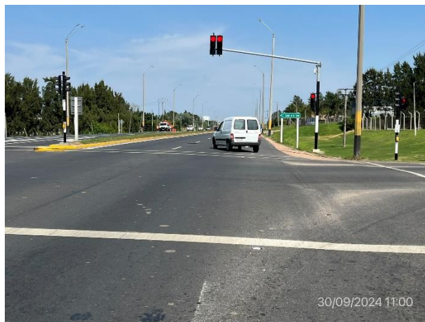
Foto 12.2-2, P03. Fin de tramo de construcción CVC SA, inicio de tramo de construcción Molinsur SA. Ruta Interbalnearia progresiva 28K950.
