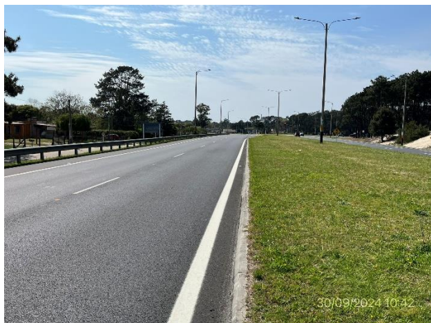
Foto 12.2-5. Ruta Interbalnearia. Cantero central, buenas condiciones de empastado y drenajes adecuados.
