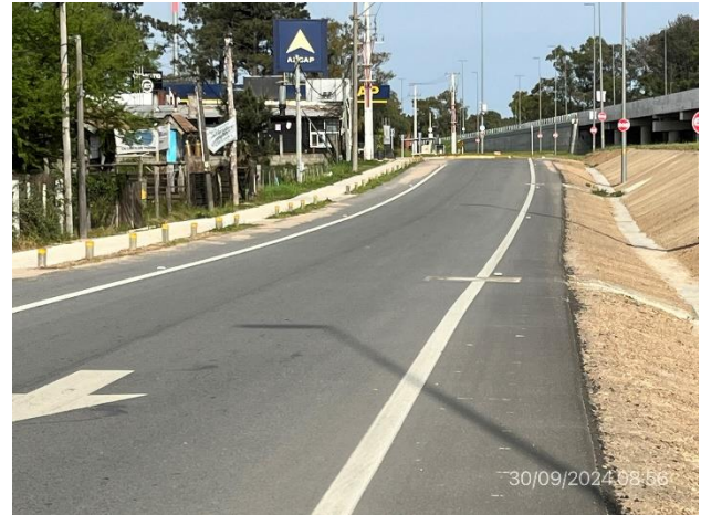
Foto 12.2-6, P01. Calle lateral en senda a (+) con nueva carpeta asfáltica y señalización terminadas
