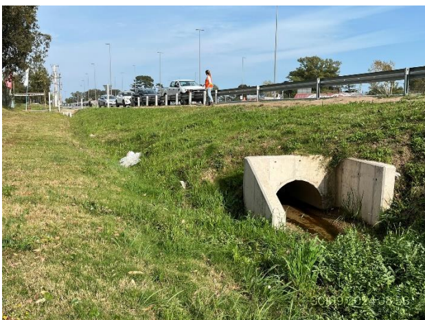
Foto 12.2-9 P01. Cabezal de red de tuberías drenantes senda a (+), buenas condiciones de empastado vegetal.
