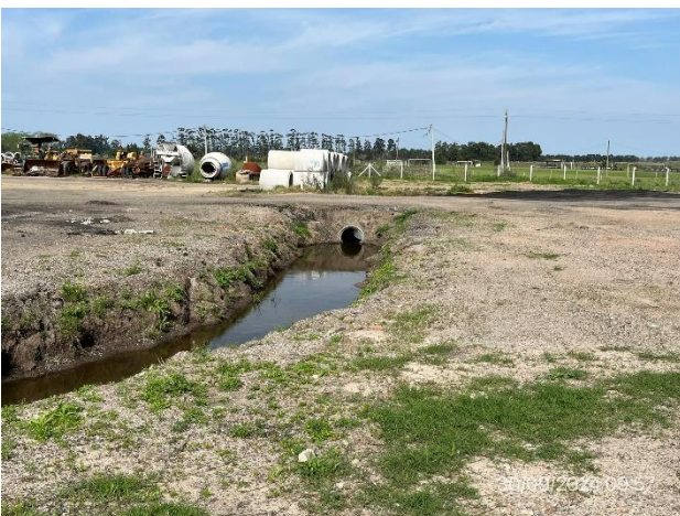
Foto 12.3-11, P06. Obrador, cañada interna atraviesa el predio del obrador.
