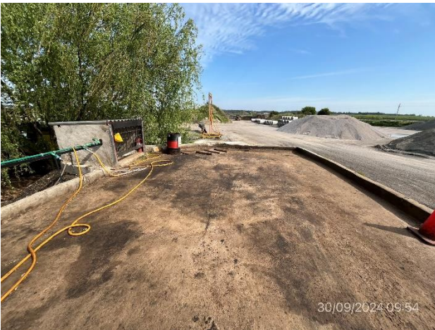
Foto 12.3-9, P06. Obrador, lavadero de camiones con pendientes hacia punto bajo de recolección de aguas oleosas.
