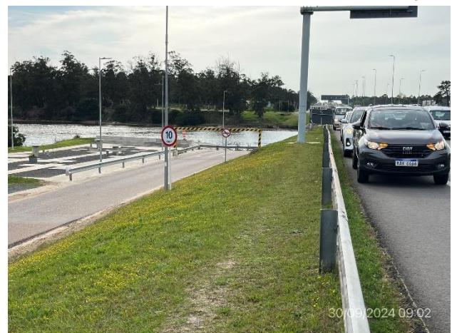
Foto 12.2-10, P01. Taludes vegetales terminados, columnas de iluminación y defensas metálicas terminadas..
