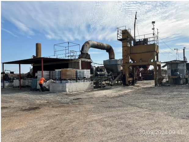
Foto 12.3-3, P06. Planta asfáltica, envellados perimetrales correctos.
