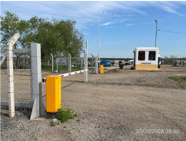
Foto 12.3-1, P06. Obrador y planta de mezcla de Molinsur S.A. Padrón 5294 de la 7ª. SC de Ciudad de la Costa.
