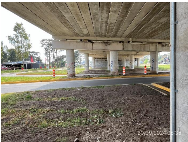
Foto 12.2-7, P01. Estructura en hormigón armado de intercambiador terminada.
