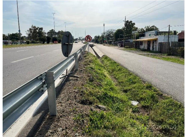
Foto 12.2-12, P02. Inicio de obra, acceso Oeste a intercambiador. Ruta Interbalnearia progresiva 50K400.
