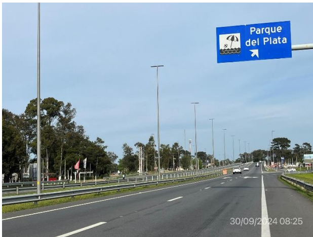
Foto 12.2-1, P03. Fin de obra, acceso Este a intercambiador. Ruta Interbalnearia progresiva 51K200.
