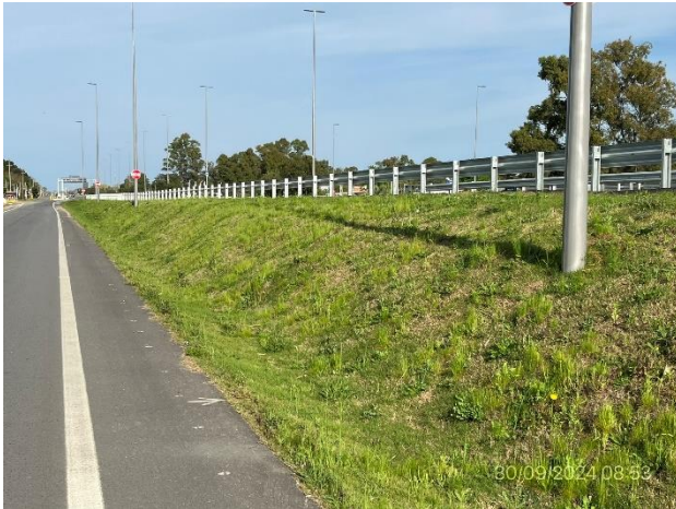
Foto 12.2-5, P01. Taludes revestidos. Obras de defensas metálicas terminadas.
