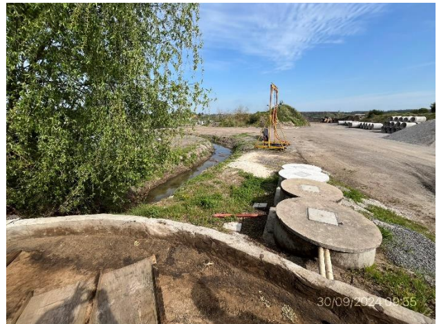
Foto 12.3-10, P06. Piletas de decantación de aguas oleosas con vertido hacia cañada interna del predio
