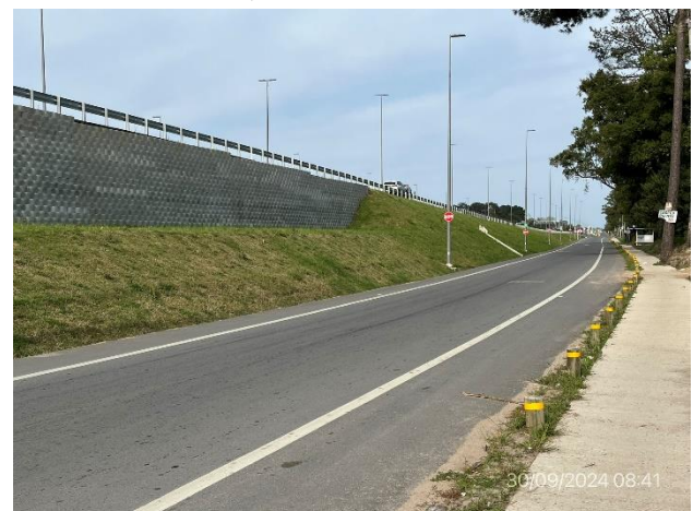
Foto 12.2-4, P01. Taludes con empastado correcto.
