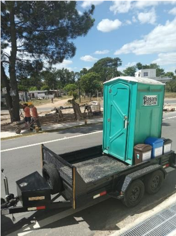
Foto 12.4-1, P01. Trailer móvil con baños y estación de residuos.
