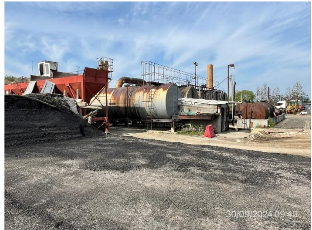
Foto 12.3-2, P06. Planta asfáltica sin actividad al momento de la auditoría.
