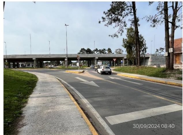
Foto 12.2-2, P01. Intercambiador terminado, calles accesorias en desnivel pavimentadas. Obras de iluminación y de señalización terminadas.
