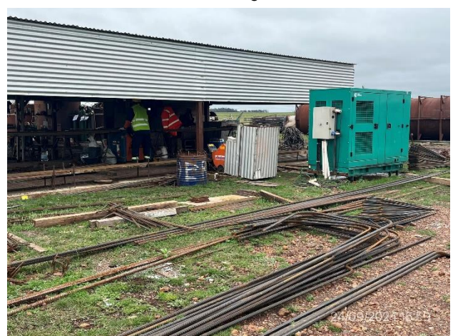
Foto 12.1-10, P04. Obrador. Sector de acopio de armaduras en proceso.
