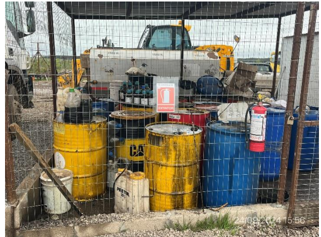
Foto 12.1-6, P04. Obrador, recipientes de hidrocarburos alojados en recinto con envallado impermeable. Recipientes correctamente rotulados.
