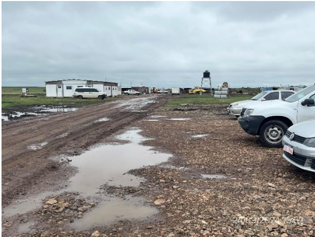
Foto 12.1-1, P04 Obrador. Vista general, accesos y explanada de maniobras.
