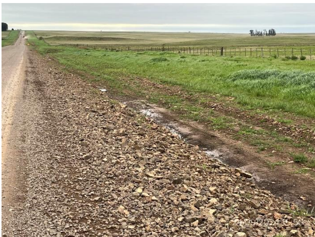
Foto 12.3-3. Tramo de Ruta 20 con drenajes conformados.
