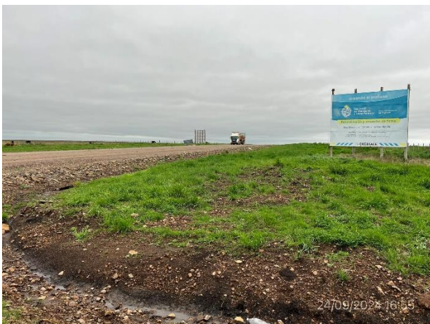
Foto 12.3-5, P01. Inicio de tramo. Ruta 20 progresiva 138K500.
