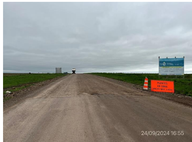
Foto 12.3-4, P01. Inicio de tramo. Ruta 20 progresiva 138K500.
