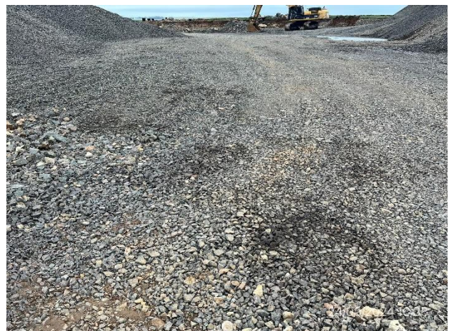
Foto 12.2-12, P03. Derrames oleosos sobre manto de áridos, aún no fue recogido ni acopiado según lo previsto en el PGA.
