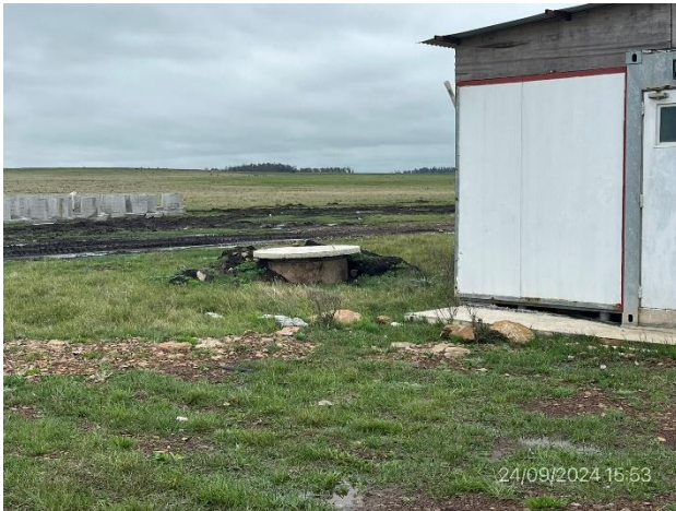
Foto 12.1-11, P04. Obrador. Depósito impermeable para aguas servidas.
