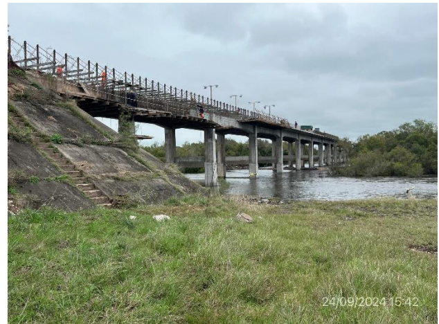
Foto 12.2-6, P02. Planicie de inundación de A° Salsipuedes en buenas condiciones, libre de ROCs.
