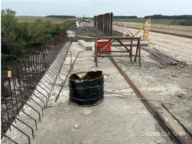
Foto 12.2-3, P02. Trabajos en ejecución en vigas New Jersey. Estación de acopio temporal de residuos.
