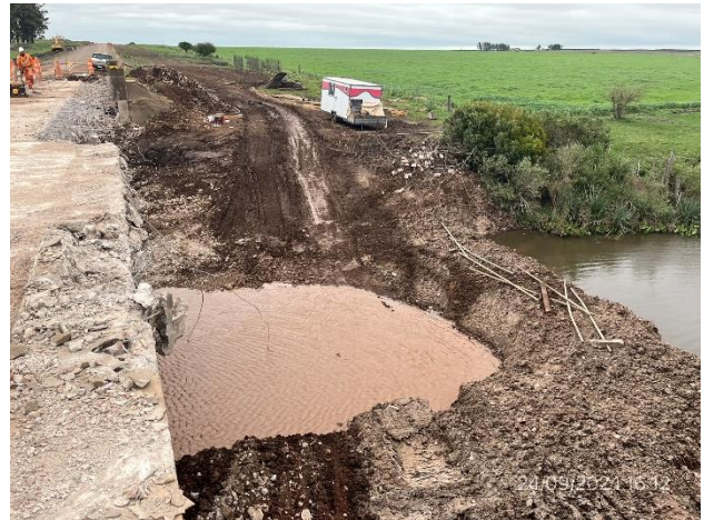
Foto 12.2-8, P01. Ataguía granular con plan aprobado por DDO.
