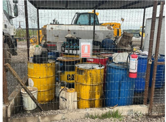
Foto 12.1-6, P04. Obrador. Recipientes de hidrocarburos alojados en recinto con envallado impermeable. Recipientes correctamente rotulados.
