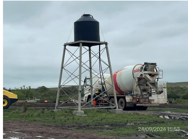
Foto 12.1-2, P04. Obrador, reservorio de agua proveniente de toma de agua con permiso de DINACEA vigente.
