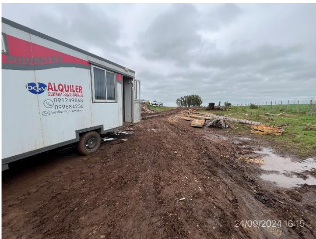
Foto 12.2-9, P01. Campamento provisorio, buenas condiciones de orden y limpieza y estructura correcta para acopio temporal de residuos.
