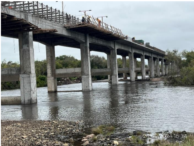
Foto 12.2-1, P02. Puente en obra sobre A° Salsipuedes. Ruta 20 progresiva 147K360. Curso de agua libre de ROCs.
