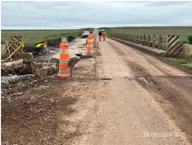
Foto 12.2-7, P01. Puente en obra sobre A° Molles. Ruta 20 progresiva 145K150.
