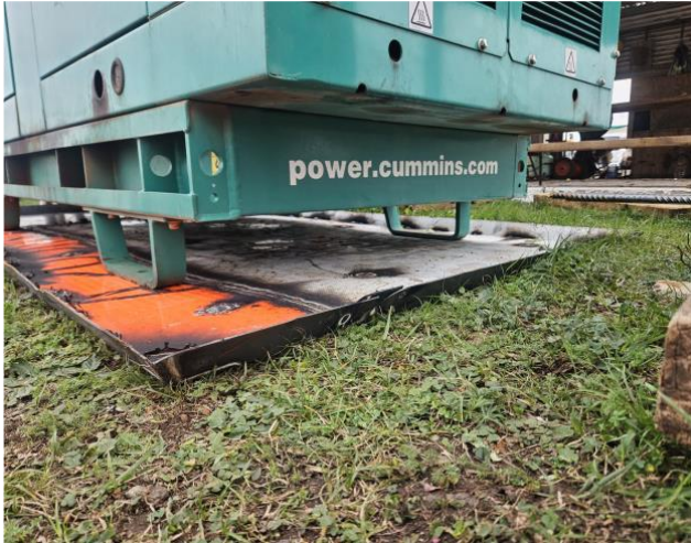
Foto 12.3-1, P04. Obrador. Se limpiaron los restos de suelo contaminado con hidrocarburos.
