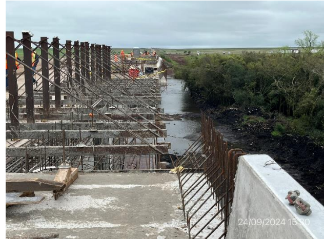
Foto 12.2-4, P02. Trabajos en ejecución en losa sobre tablero existente. Buenas condiciones de orden y limpieza.
