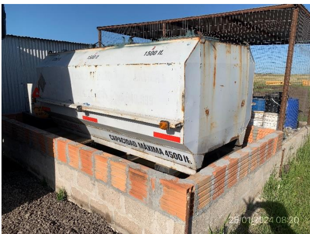
Foto 12.1-7, P04. Obrador. Tanque de combustible alojados en recinto con envallado impermeable.
