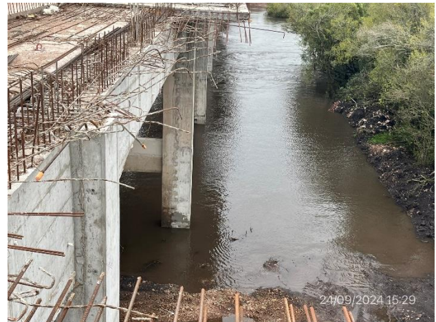
Foto 12.2-2, P02. Recrecido de pilares de pórticos intermedios ejecutados. Curso de agua libre de ROCs u otros residuos.
