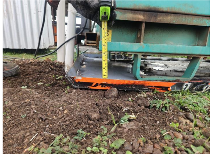
Foto 12.3-2, P04. Obrador. Se dotó al grupo electrógeno de bandeja estanca para prevenir derrames.
