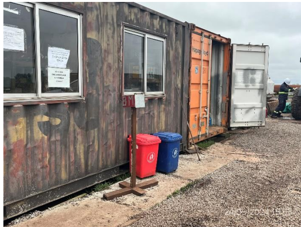
Foto 12.1-3, P04. Obrador, estación de acopio temporal de residuos segregados según corriente de generación.
