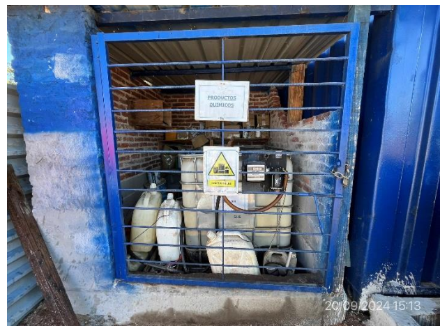
Foto 12.1-4, P05. Obrador, sector envallado para acopio de productos peligrosos. El volumen envallado es insuficiente.
