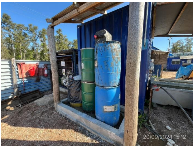
Foto 12.1-3, P05. Obrador, recinto techado para acopio temporal de residuos contaminantes
