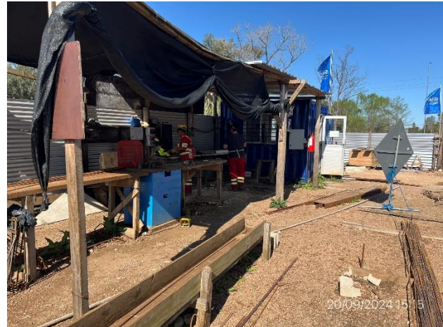
Foto 12.1-2, P05. Obrador, explanada de acopio de armaduras y taller de proceso de refuerzos.
