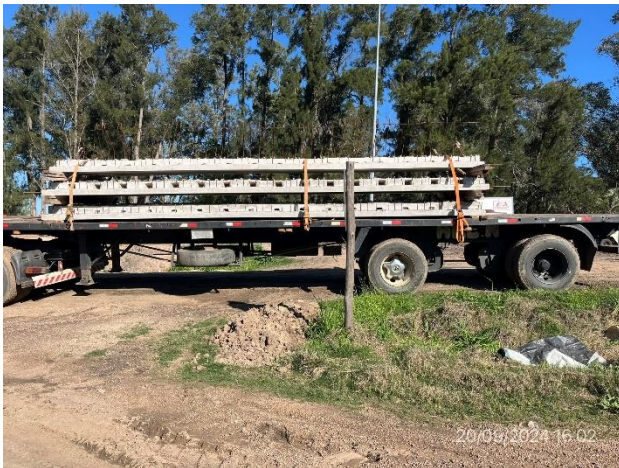
Foto 12.2-9, P01. Acopio de viguetas prefabricadas próximo a su sitio de descarga.
