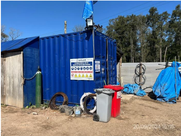
Foto 12.1-1, P05. Obrador, estación de acopio de residuos segregados.
