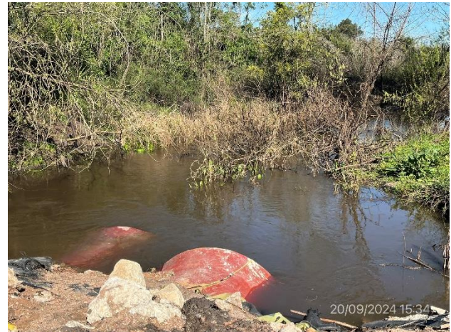
Foto 12.2-8, P01. Ataguía granular y entubamiento de A° Canelón Chico.
