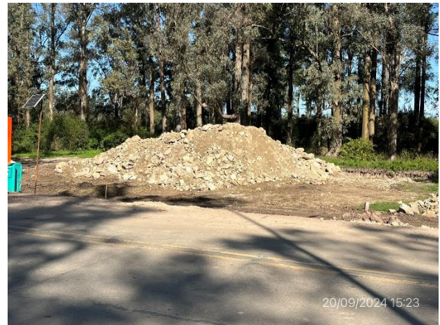
Foto 12.2-6, P01. Acopio de ROCs previos a su disposición final.
