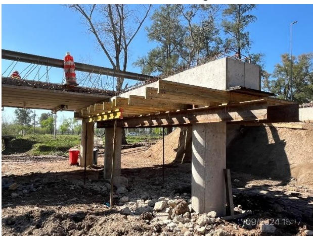
Foto 12.2-11, P02. Viga dintel construida y desencofrada. Buenas condiciones de orden y limpieza.
