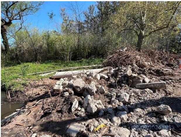
Foto 12.2-5, P01. Acopio de armaduras previo a su disposición final.
