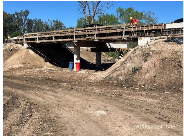
Foto 12.2-10, P02. Puente secundario sobre Arroyo Canelón Chico. Ruta 11 progresiva 99K450.
