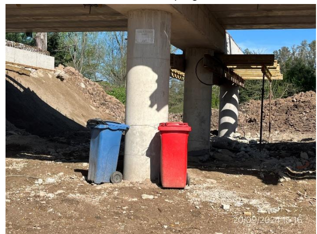
Foto 12.2-12, P02. Estación para acopio temporal de residuos segregados por origen de generación.
