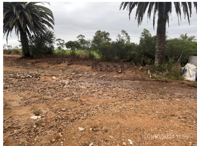
Foto 12.1-12, P03. Acopio de armaduras ensambladas.
