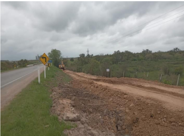
Foto 12.3-3, P01. Se demarcó la cota de máxima inundación.
