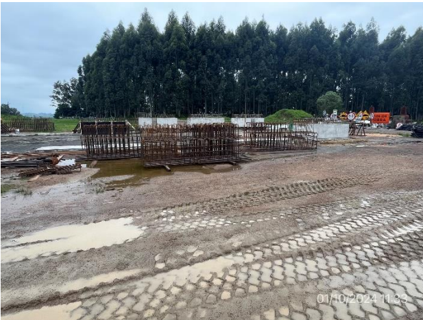
Foto 12.2-3, P04. Explanada para acopio de armaduras
