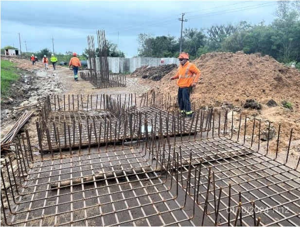
Foto 12.1-7, P02. Acopio de armaduras preconformadas.
