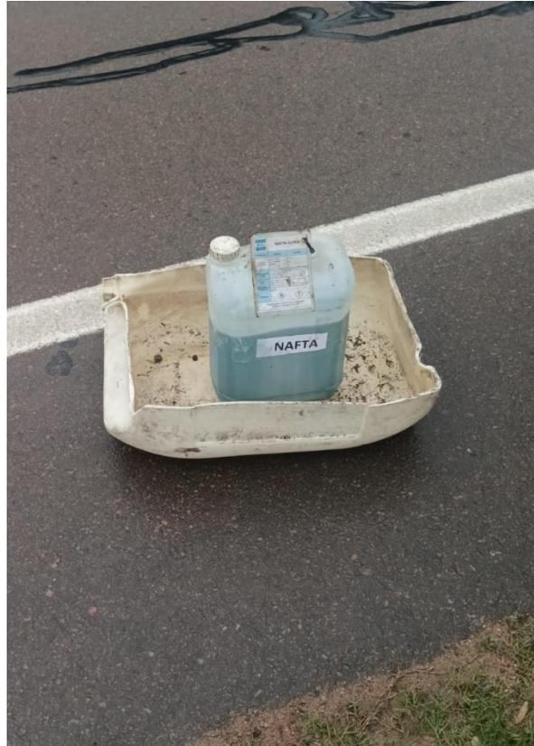
Foto 12.3-1. P05, la empresa dotó al móvil de apoyo de una bandeja para realizar las maniobras de aprovisionamiento de combustible a la maquinaria liviana.
