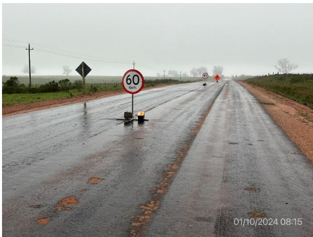
Foto 12.1-3 Tramo de Ruta 7 con reciclado cementado imprimado en ambas sendas.
