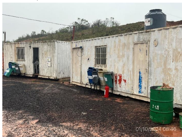
Foto 12.2-6, P03. Estación correcta para acopio temporal de residuos segregados por corriente.
