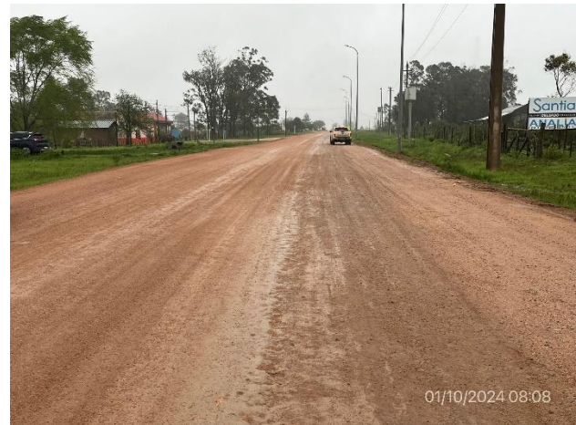
Foto 12.1-2. Tramo de Ruta 7 con reciclado cementado ejecutado en ambas sendas.
