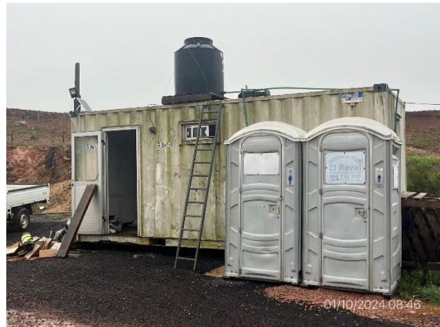
Foto 12.2-10, P03. Baños químicos. Reservorio de agua no potable proveniente de fuente de libre disponibilidad en tajamar natural en cantera.
