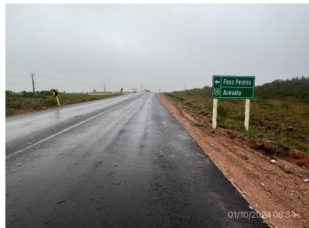
Foto 12.1-6, P02. Fin del tramo. Ruta 7 progresiva 292K500, empalme con Ruta 38.
