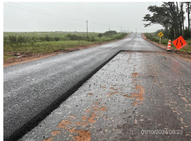
Foto 12.1-4. Tramo de Ruta 7 con nueva carpeta asfáltica ejecutada en media calzada
