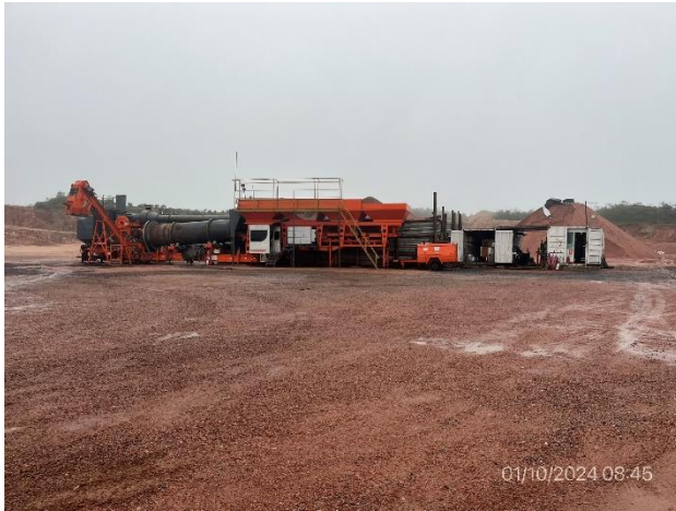
Foto 12.2-13, P03. Planta asfáltica y explanada de maniobras y acopio de áridos.
