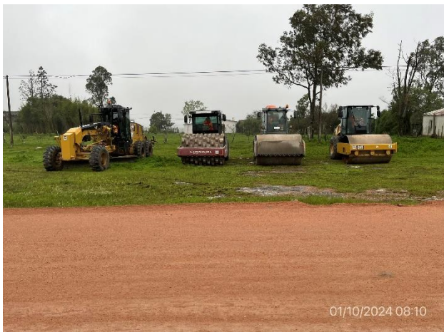
Foto 12.2-1. P06, frente de obra y campamento móvil. Ruta 7 progresiva 285K700 a (+).
