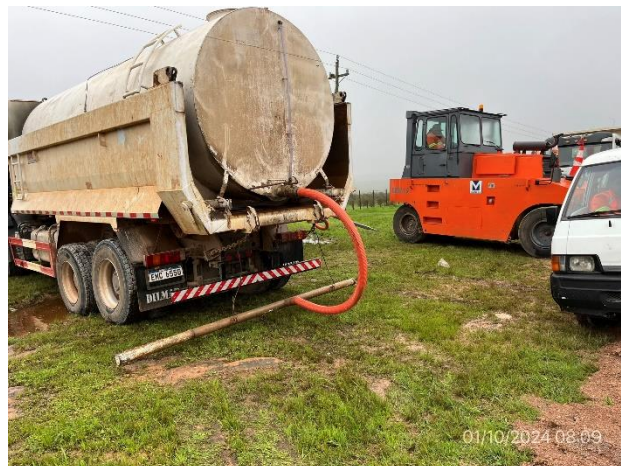
Foto 12.2-2. P06. No hay infraestructura para acopio temporal de residuos.
