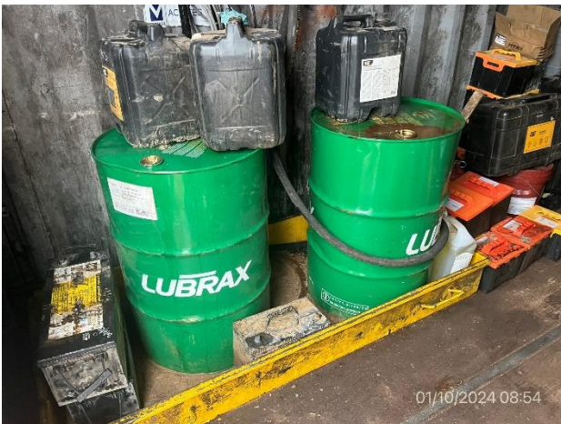
Foto 12.2-11, P03. Local cerrado para acopio de lubricantes con envallado correcto.
