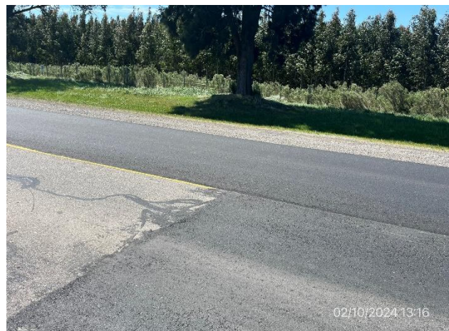
Foto 12.1-6. Ruta 3, recapado terminado senda a (+).
